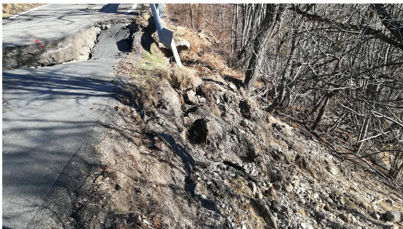
Foto 2 – Vista della scarpata a valle strada (19/02/2019).
