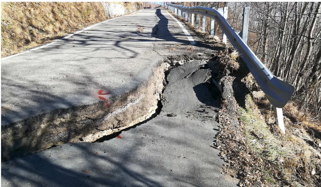
Foto 3 – Particolare dell’abbassamento del piano viabile della strada provinciale (19/02/2019).
