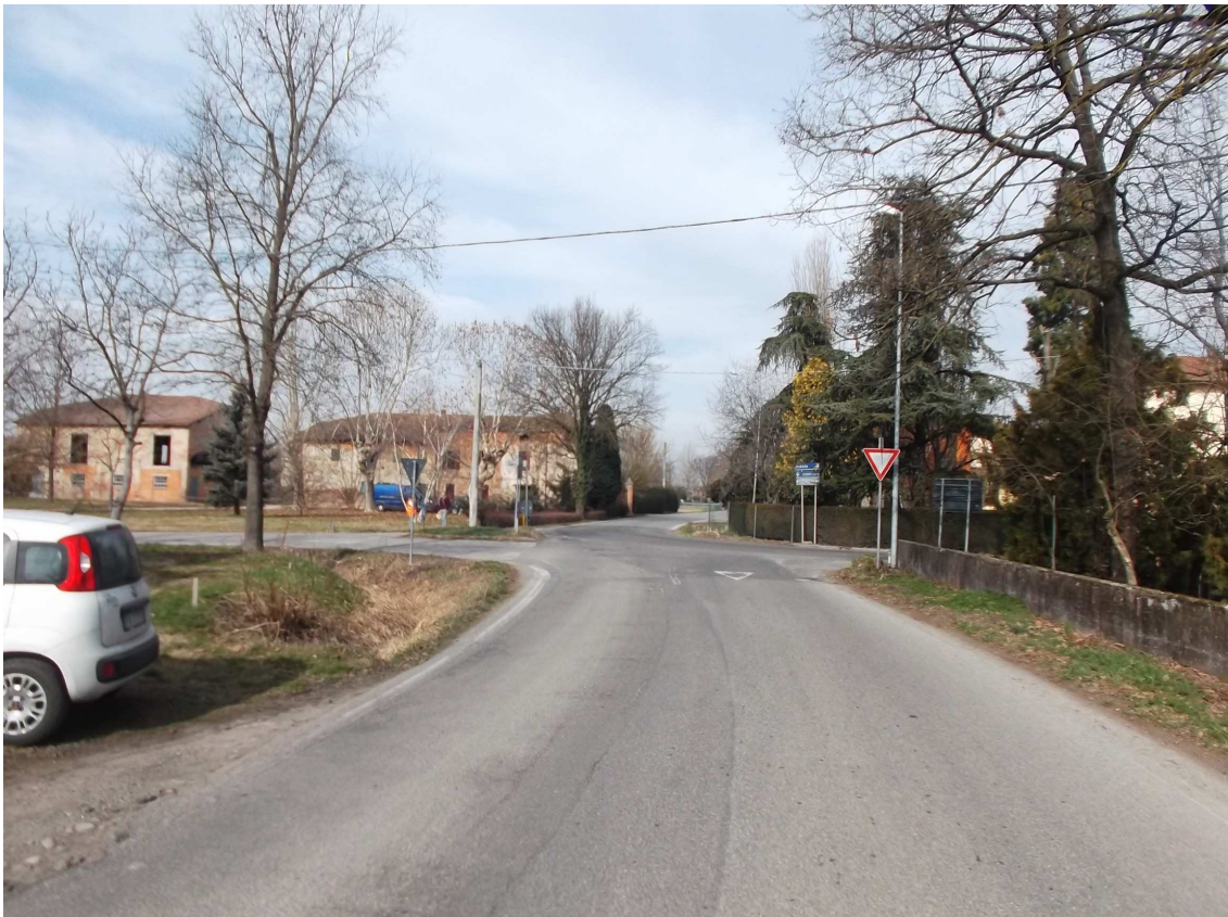
VISTA DALL'INTERNO DI VIA DEGLI ORATORI
