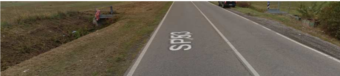
Lato da prevedere tombamento
