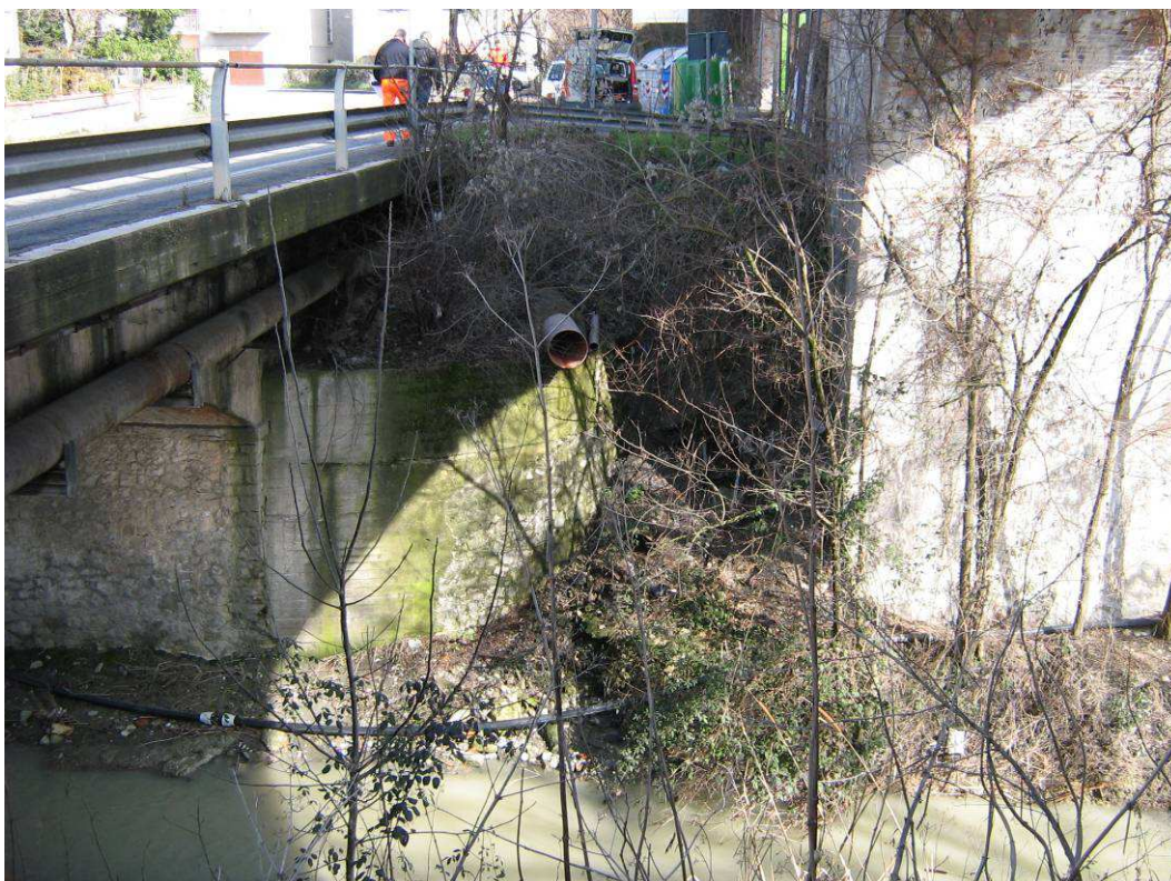
Foto 04: vista su scarpata destra, muro di contenimento della spalla del ponte stradale con sottoservizi staffati a bordo ponte, pila del ponte ferroviario a destra e tubazioni di scarico in PVC.
