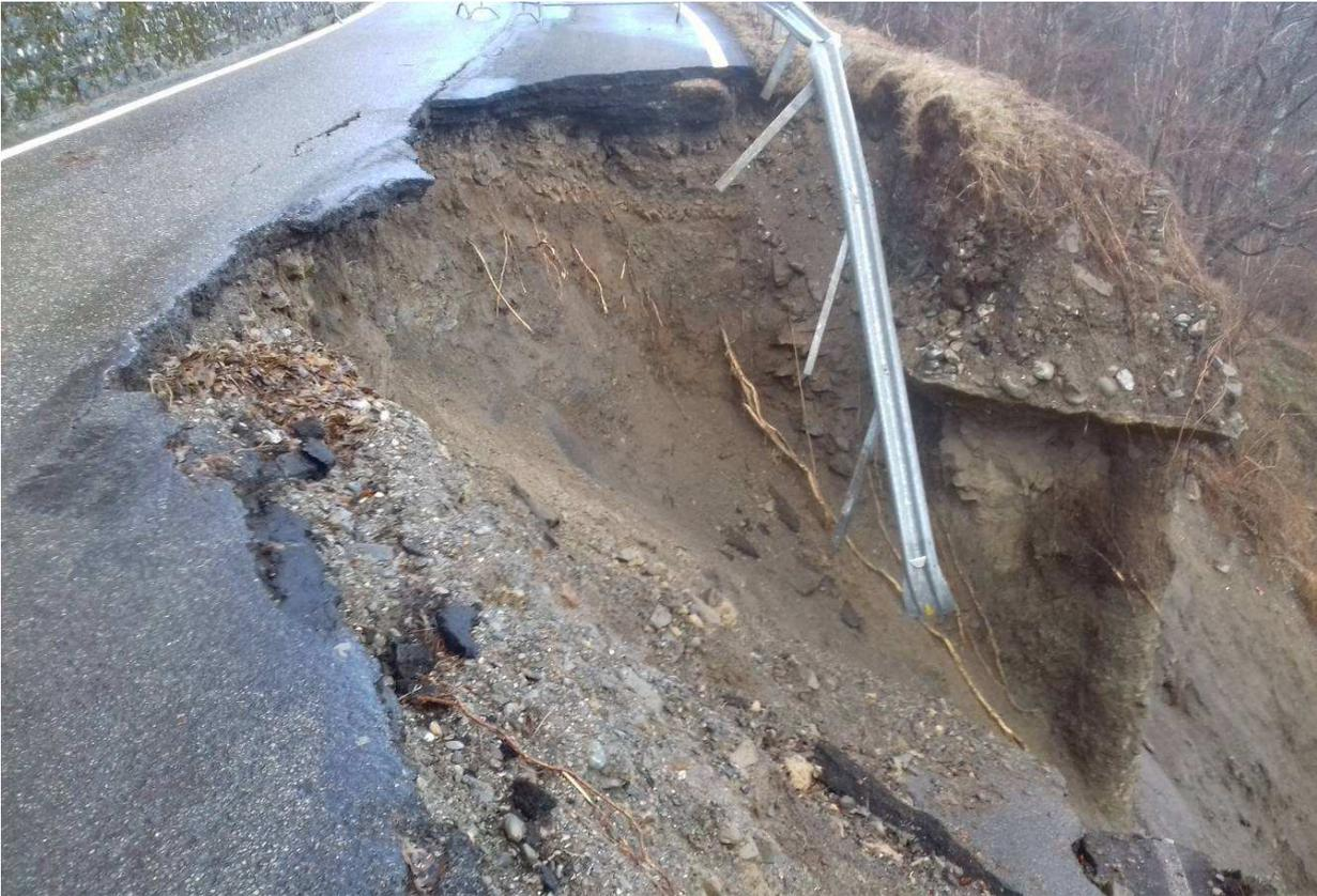
Foto 2 – Vista da sud del tratto interessato dal cedimento della sede stradale, si vede anche l'opera di sostegno realizzata nel 2002-2003.
