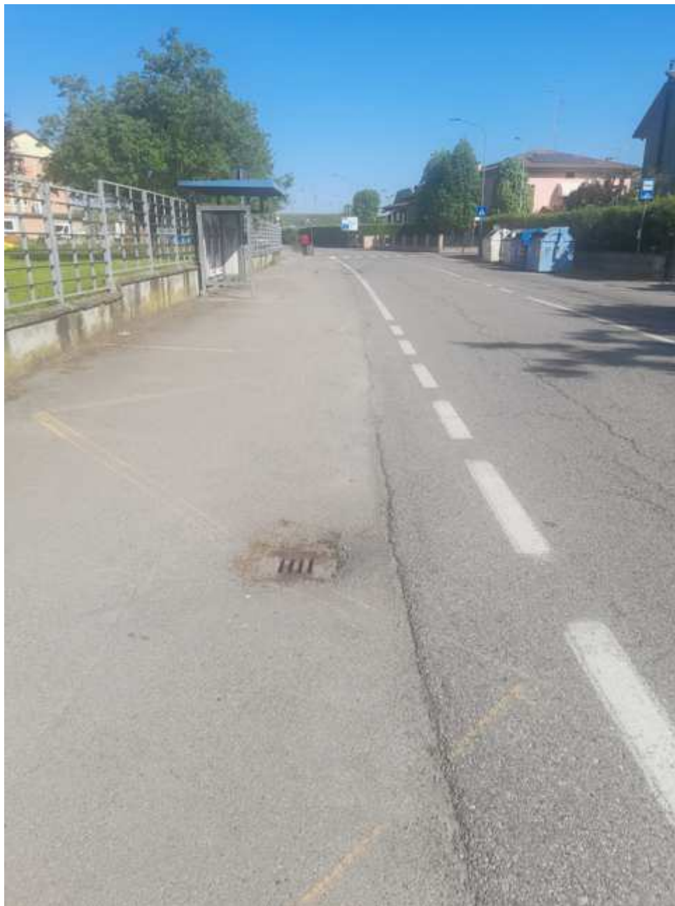
Via Moro lato Ovest
