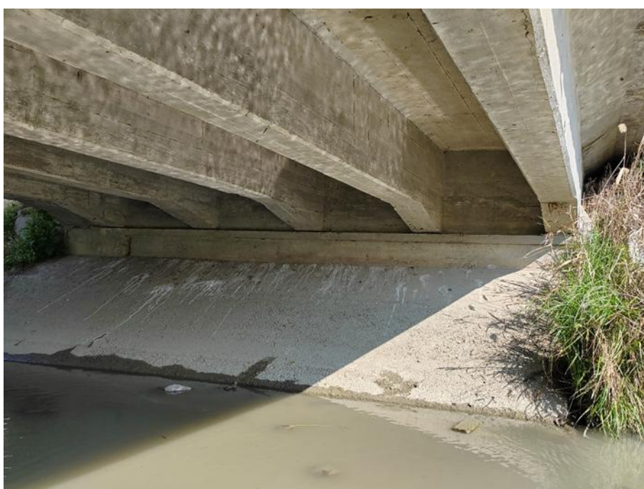
Figura 2.6: Vista da intradosso impalcato
