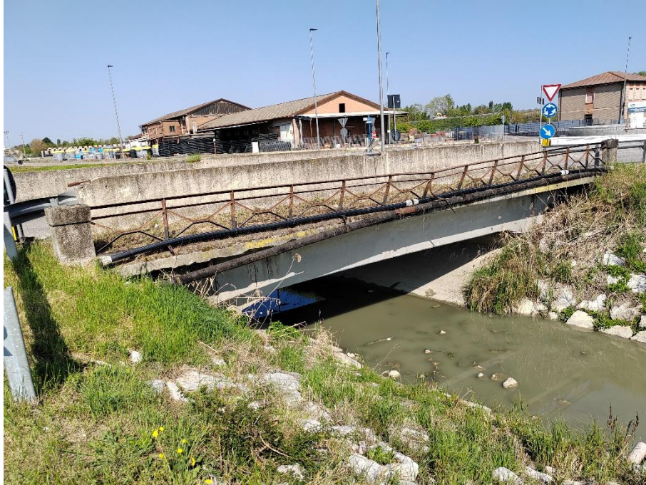
Figura 2.7: Vista longitudinale lato valle
