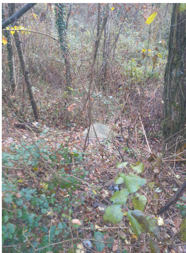
Foto 2 - Tubo di attraversamento del fognolo stradale
