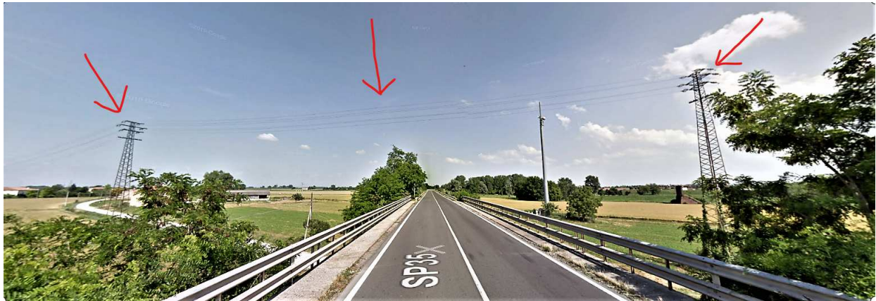
Figura 5 - Vista della linea elettrica aerea dalla SP35 - fonte Google Maps
