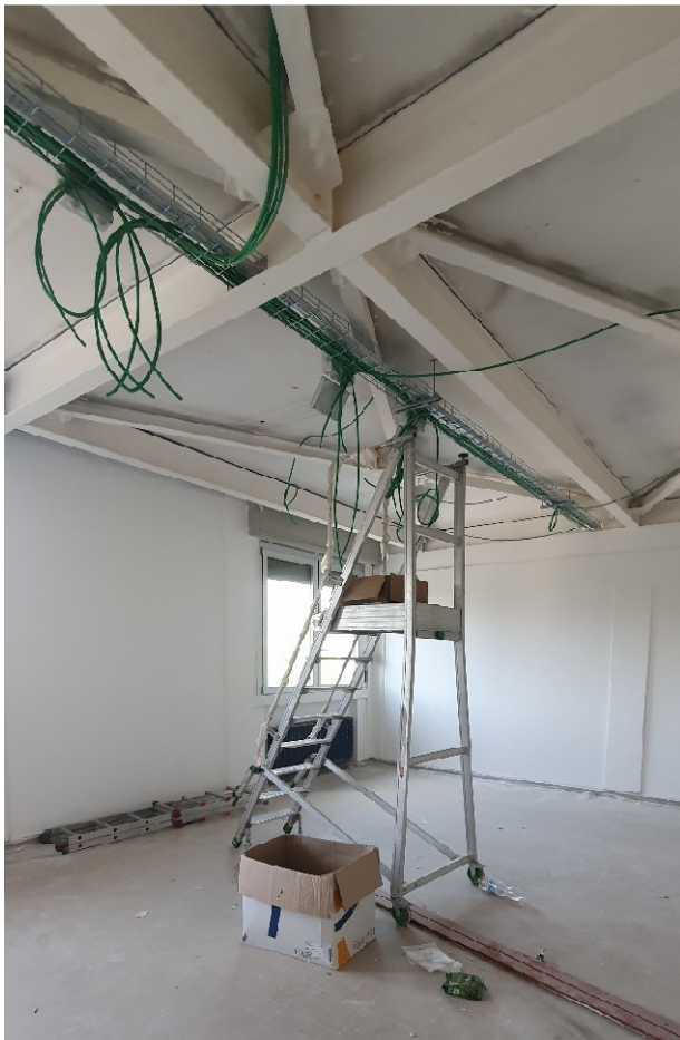
PRESA FOTOGRAFICA N.1 – Rifacimento impianti elettrici
