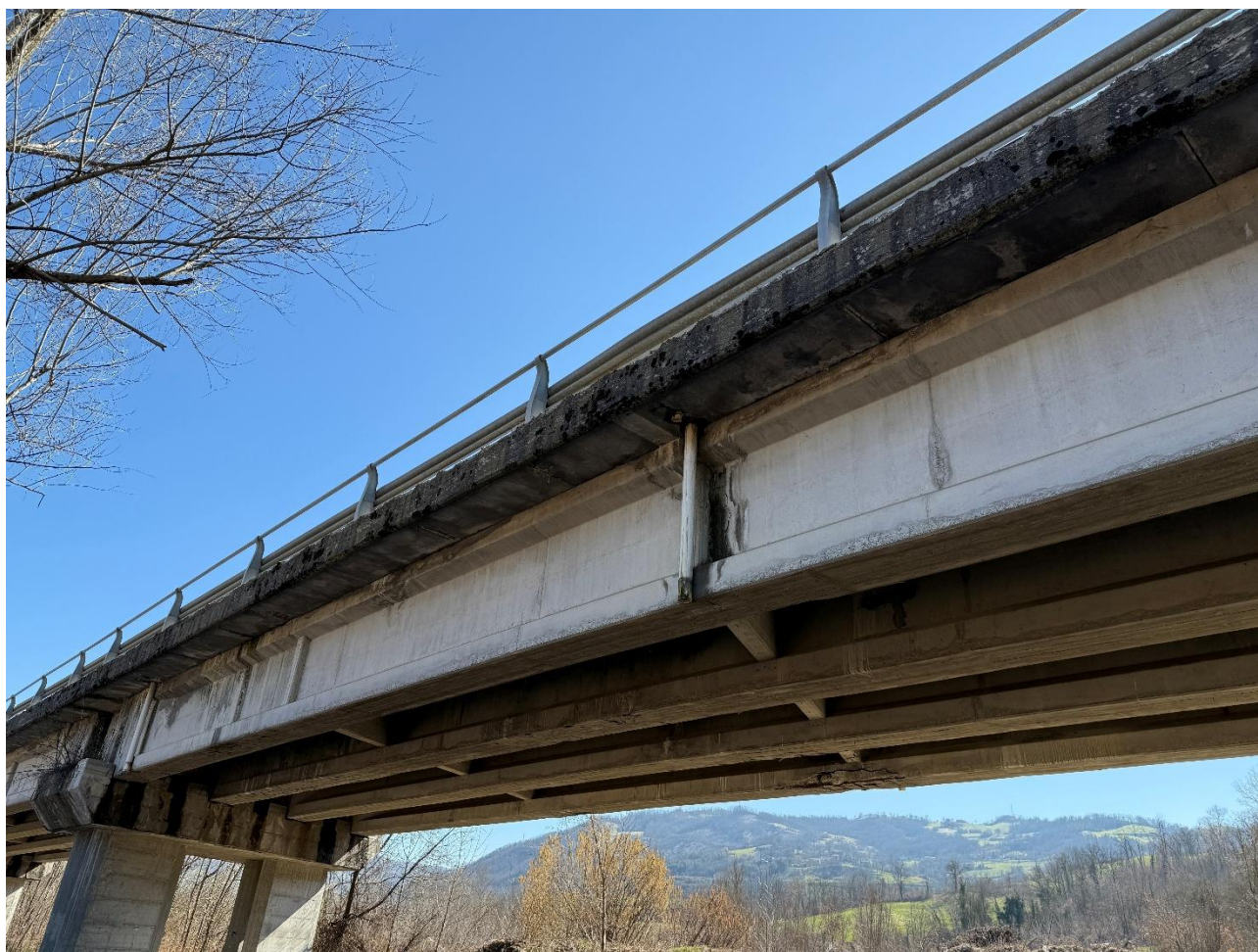
2.1 Foto del ponte
