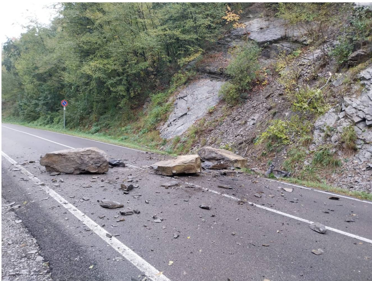
Foto 1 – Particolare dei massi crollati sulla sede stradale della SP 9 al km 19+400 il giorno 20/10/2025.
