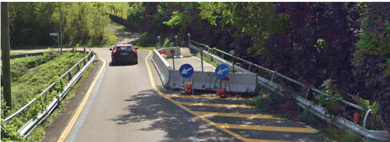
Figura 5 - Vista area di intervento
