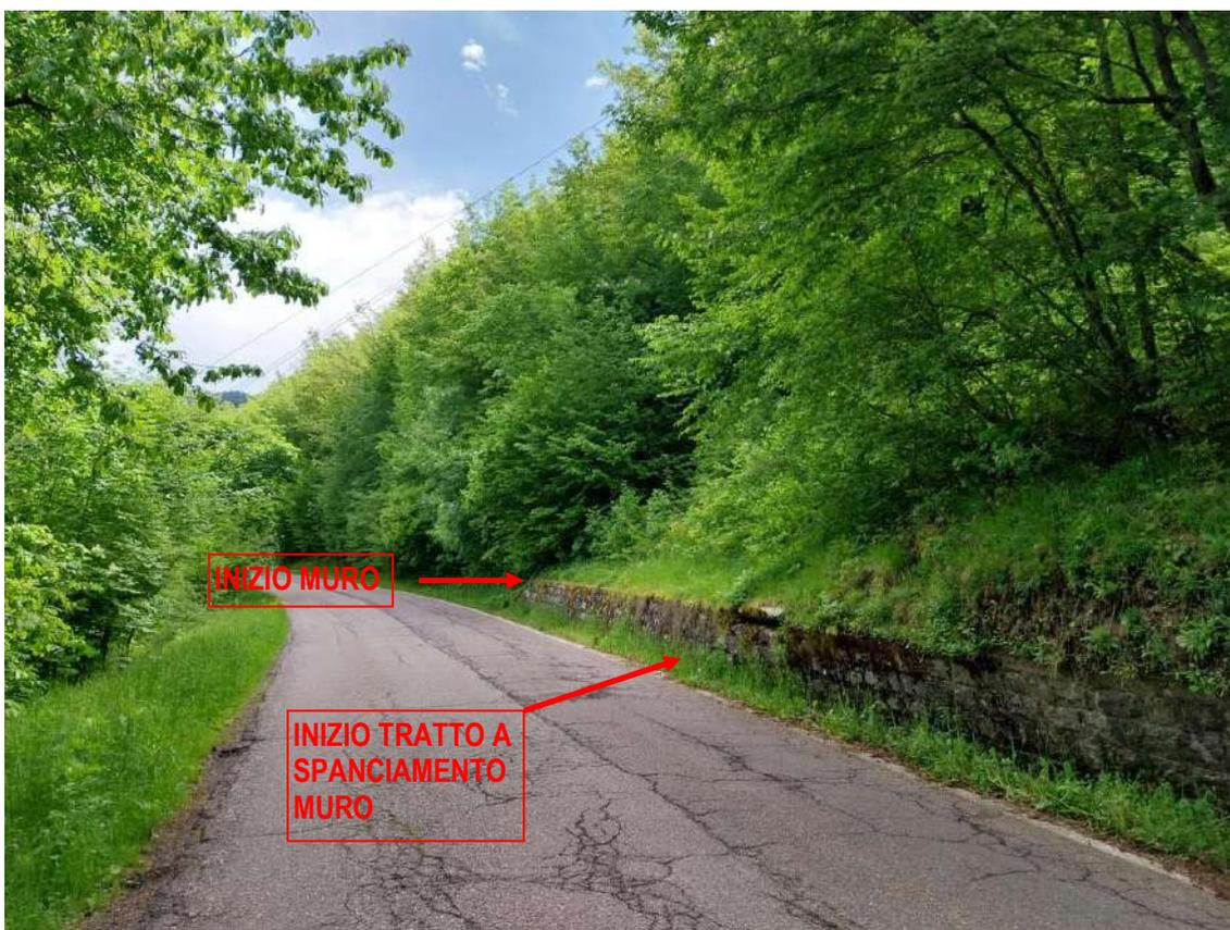
Foto 1- Vista del muro di sasso a sostegno della scarpata monte spanciato e Inizio del TRATTO A
