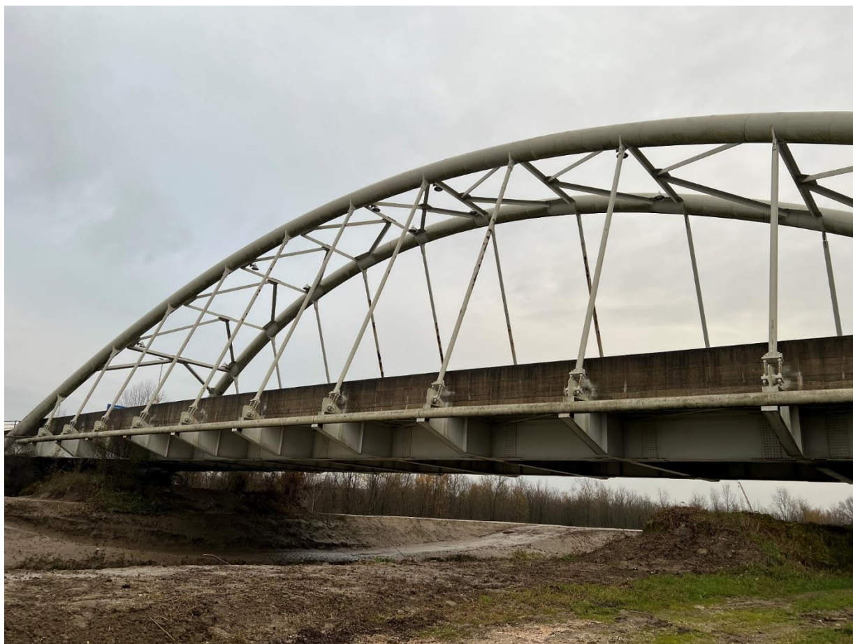
Foto 1– vista lato valle
