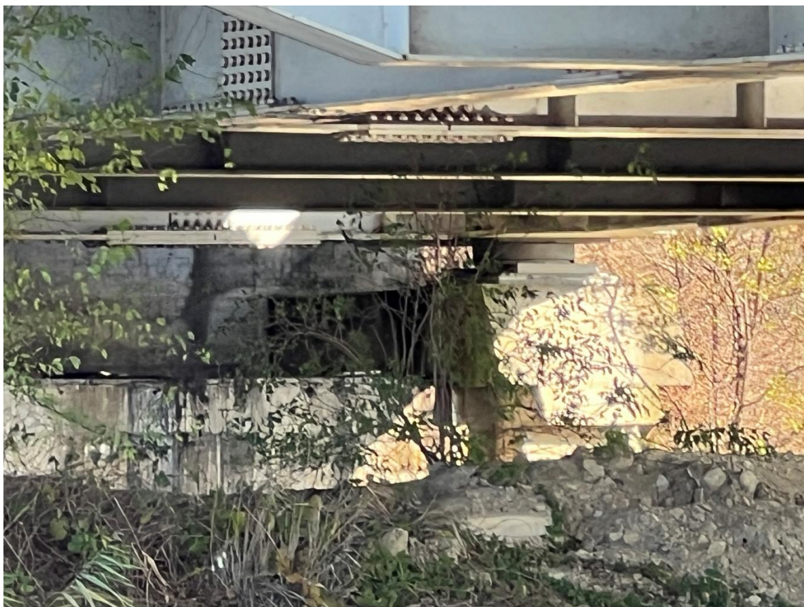
Foto 8 spalla dx e appoggio lato monte
