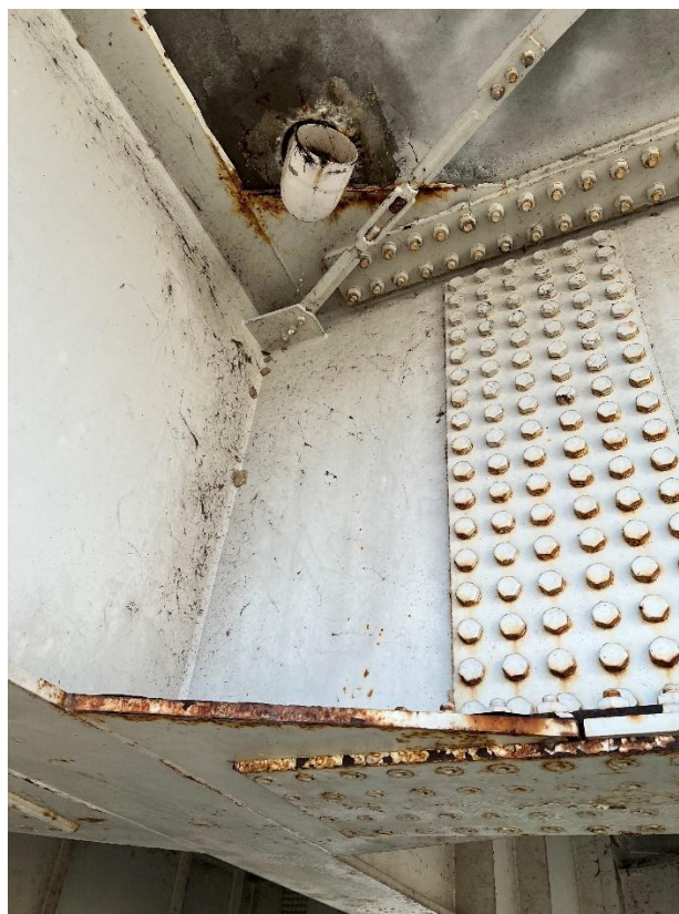
Foto 5 dettaglio giunto e scarico acque impalcato
