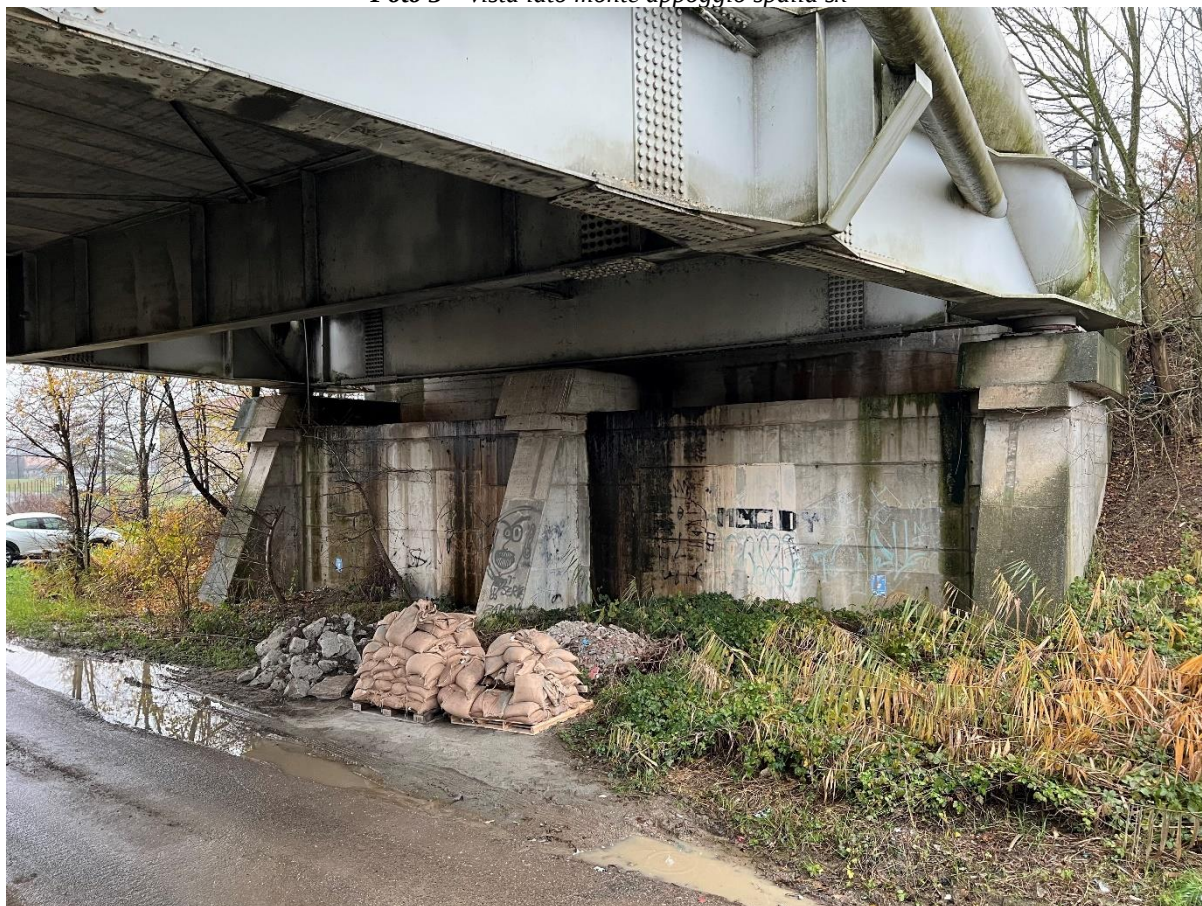
Foto 3 – vista lato monte appoggio spalla sx
