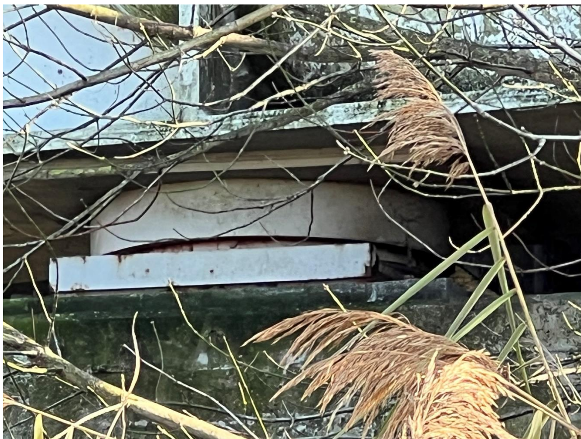
Foto 9 – Apparecchio di appoggio spalla sx lato valle
