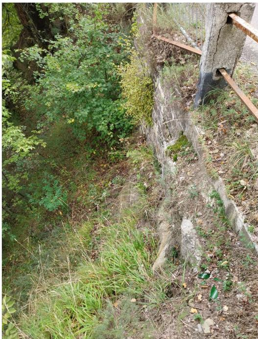
Foto 3 – vista del muro sottoscarpa con crolli
