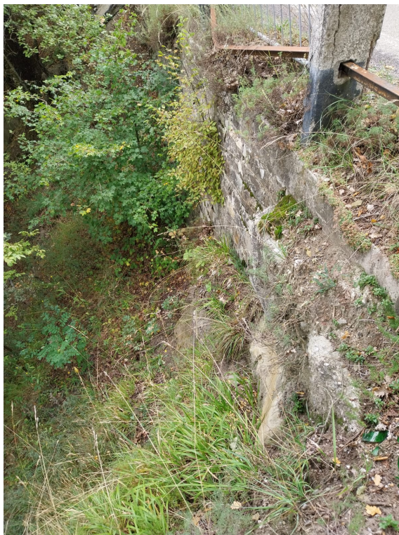
Foto 1 – vista del muro sottoscarpa
