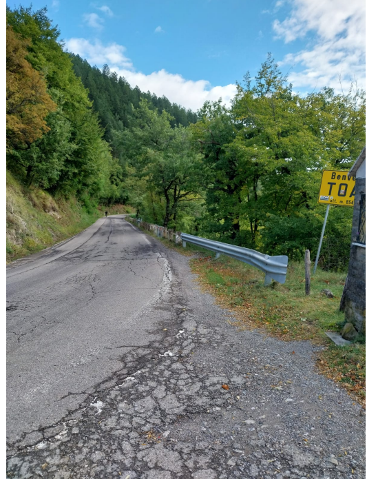
Foto 5 – Porzione della sede stradale oggetto d'intervento.
