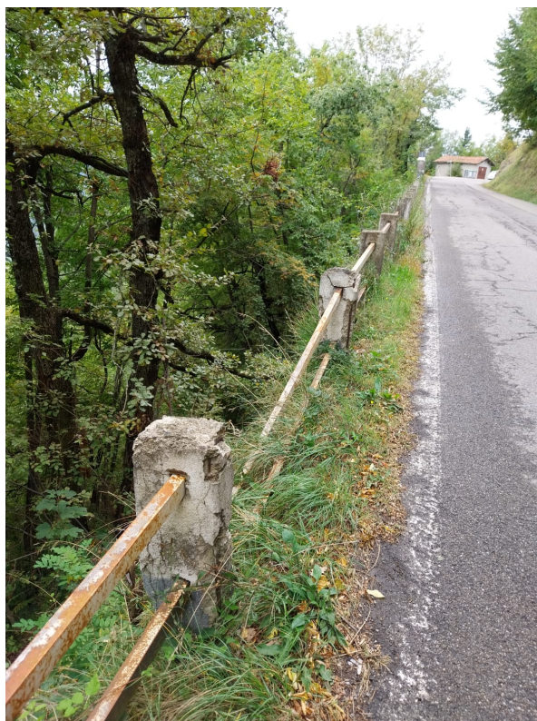
Foto 2 – vista laterale del muro sottoscarpa e dei sistemi di ritenuta
