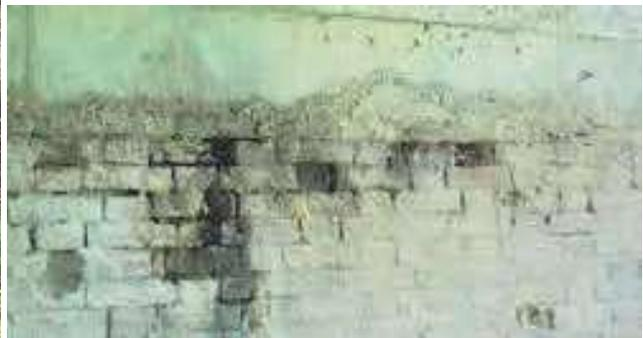
In seguito a un'attenta ispezione visiva delle pile, come si evince dalle foto riportate precedentemente, si può constatare un avanzato stato di degrado della muratura in corrispondenza delle pile.
