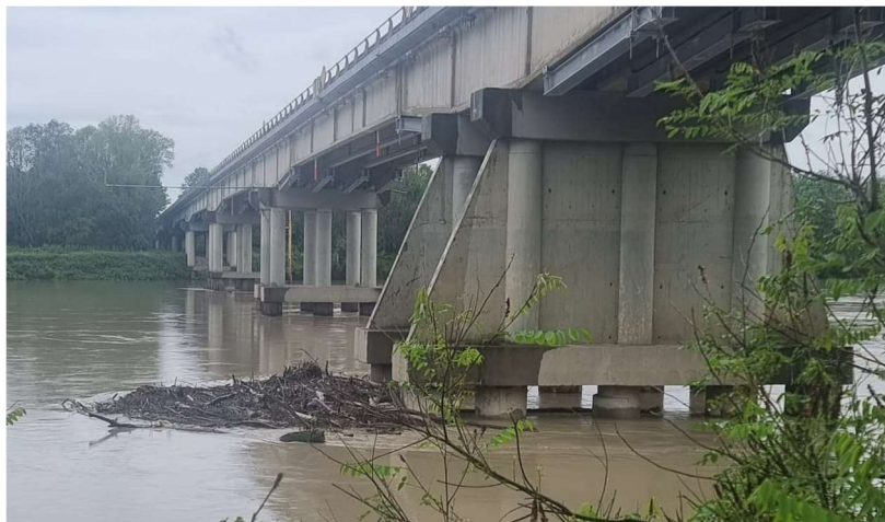
Foto del 17.05.2023 – pila 9
