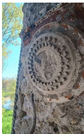
Testa di partenza del 4° cavo presso pila 10
