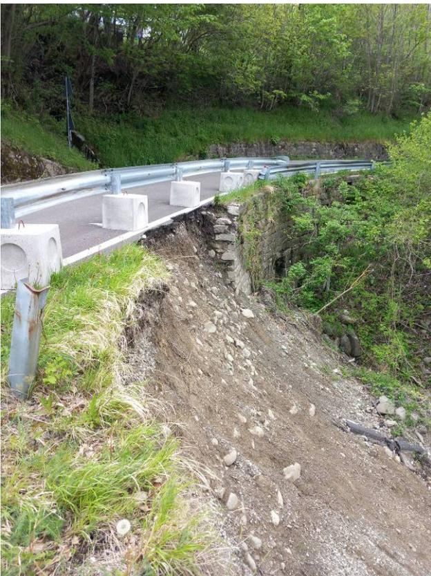
Foto 5 - vista del dissesto del versante di valle, a lato del muro esistente, con interessamento della carreggiata stradale
