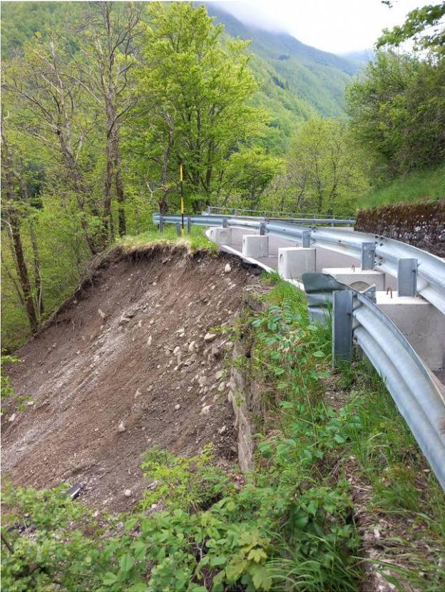
Foto 4 - vista del dissesto del versante di valle con interessamento della carreggiata stradale
