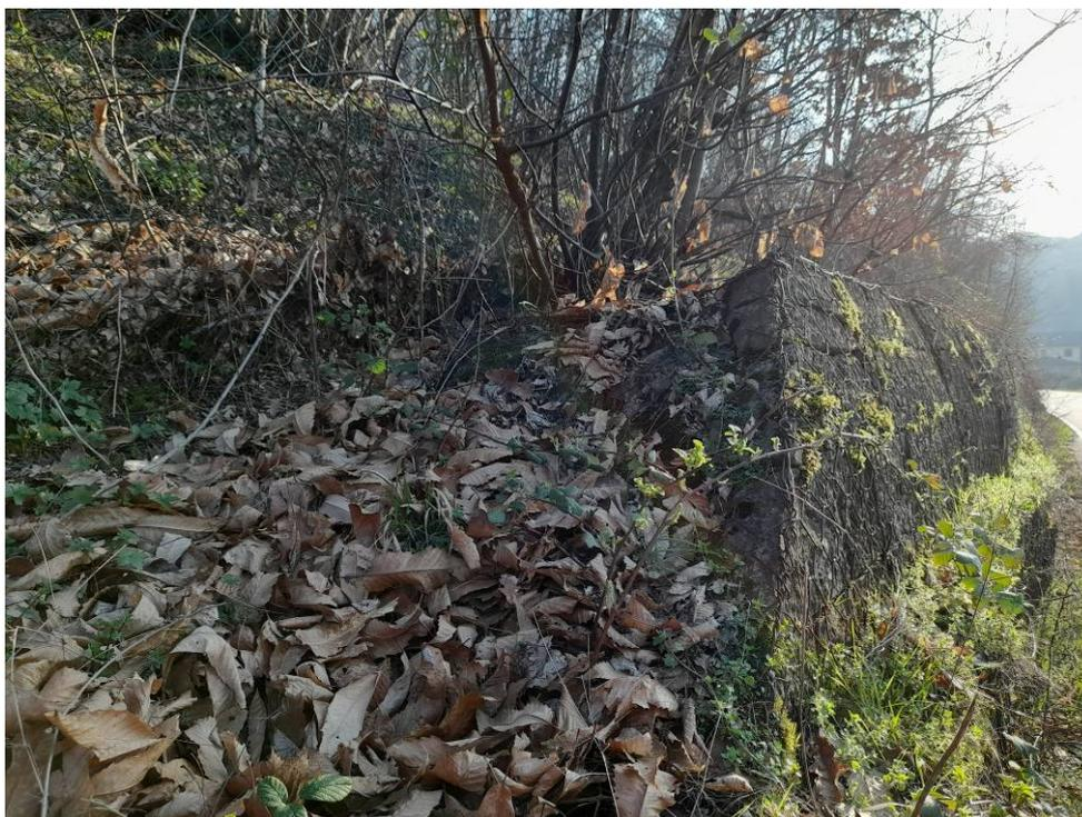
Foto 3 – dettaglio vista laterale della gabbionata di monte da cui si può notare lo “spanciamiento” del manufatto
