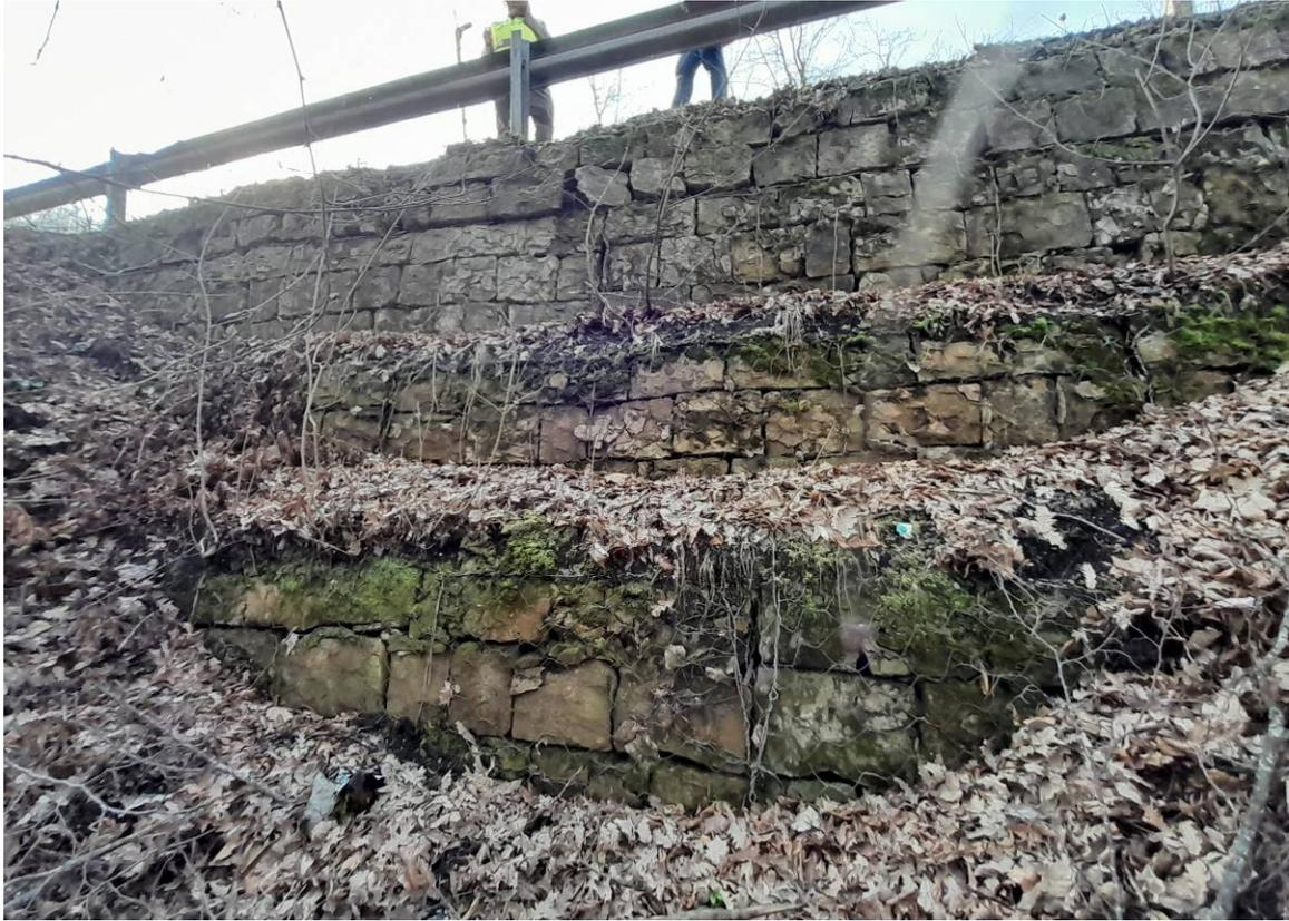
**Foto 6 – vista frontale del muro sottoscarpa composto da tre file di gabbioni**
