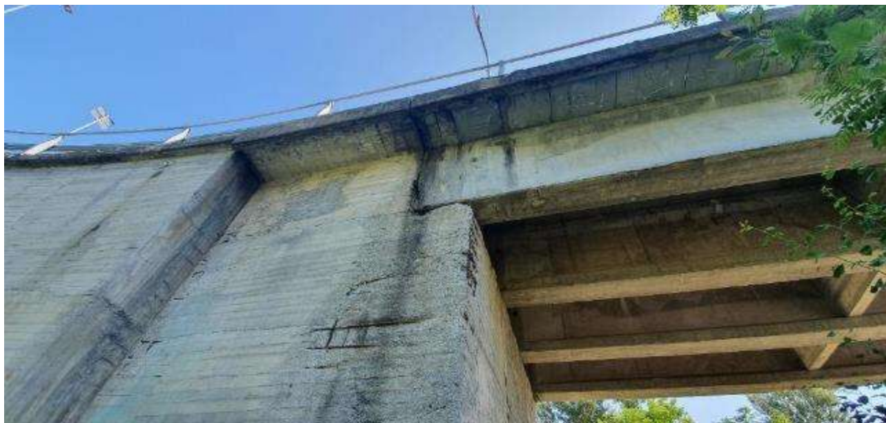
Figura 5 - Vista spalla di appoggio ovest
