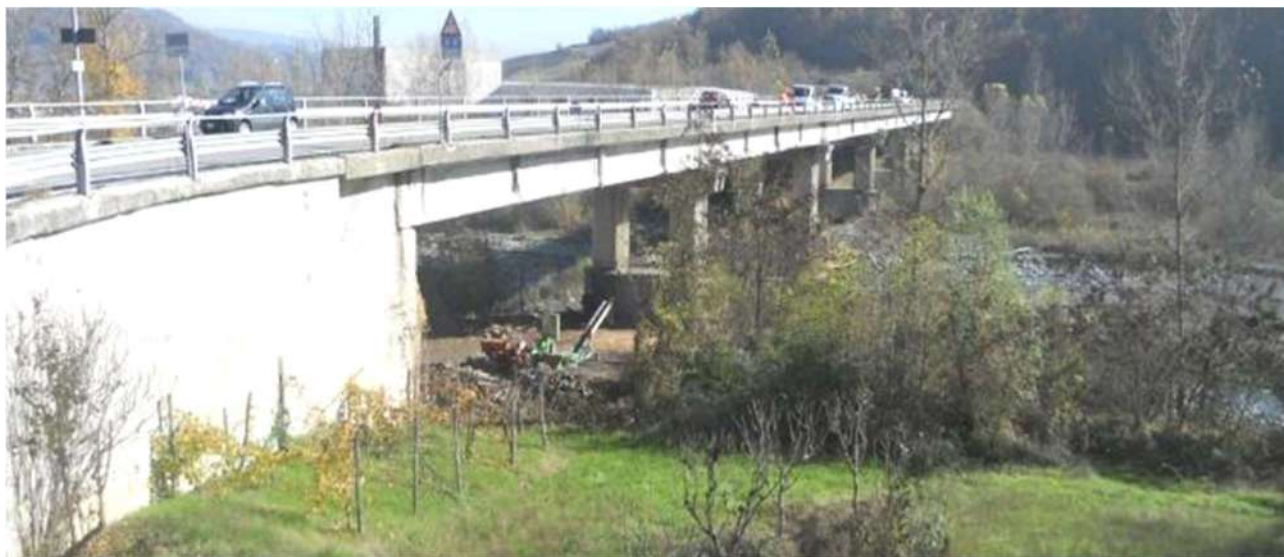
Figura 4 - Vista laterale sud
