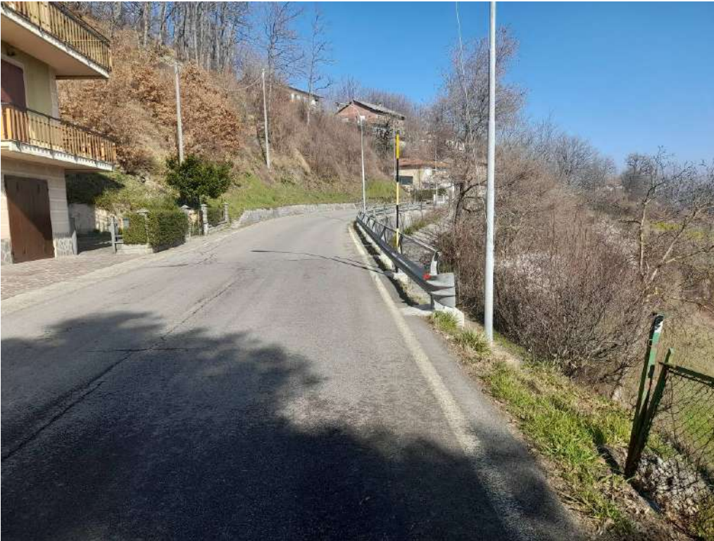
Foto 5 - vista della barriera stradale su muro B, del cordolo sommitale del muro e dei pali di pubblica illuminazione
