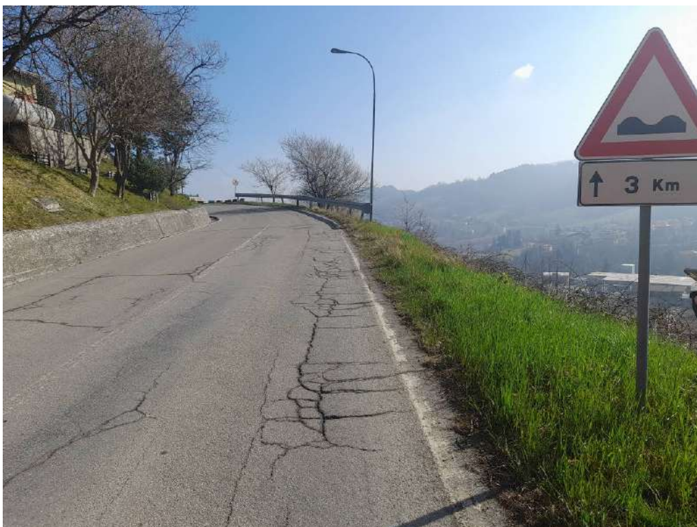
Foto 1 – vista del tratto stradale oggetto di intervento e dei degradi della pavimentazione stradale
