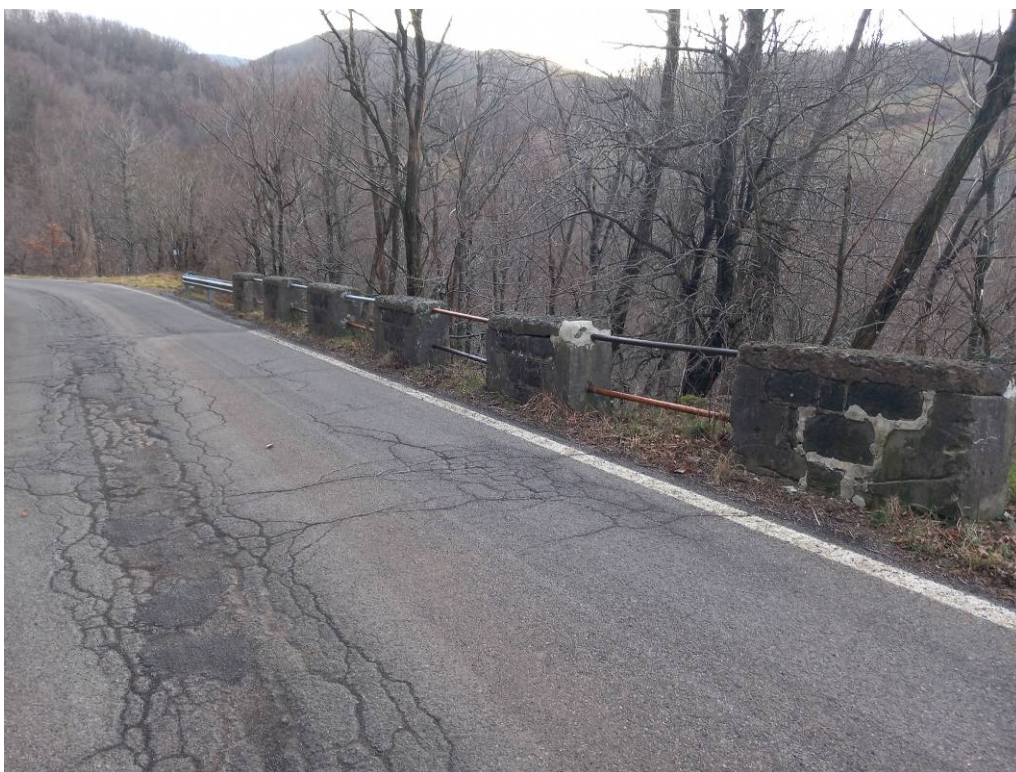
Foto 6 - vista del tratto stradale e dei sistemi di ritenuta in corrispondenza del muro D, Intervento 03; si nota il degrado del piano viabile con presenza di fessurazioni longitudinali e ramificate e presenza di buche e rappezzi
