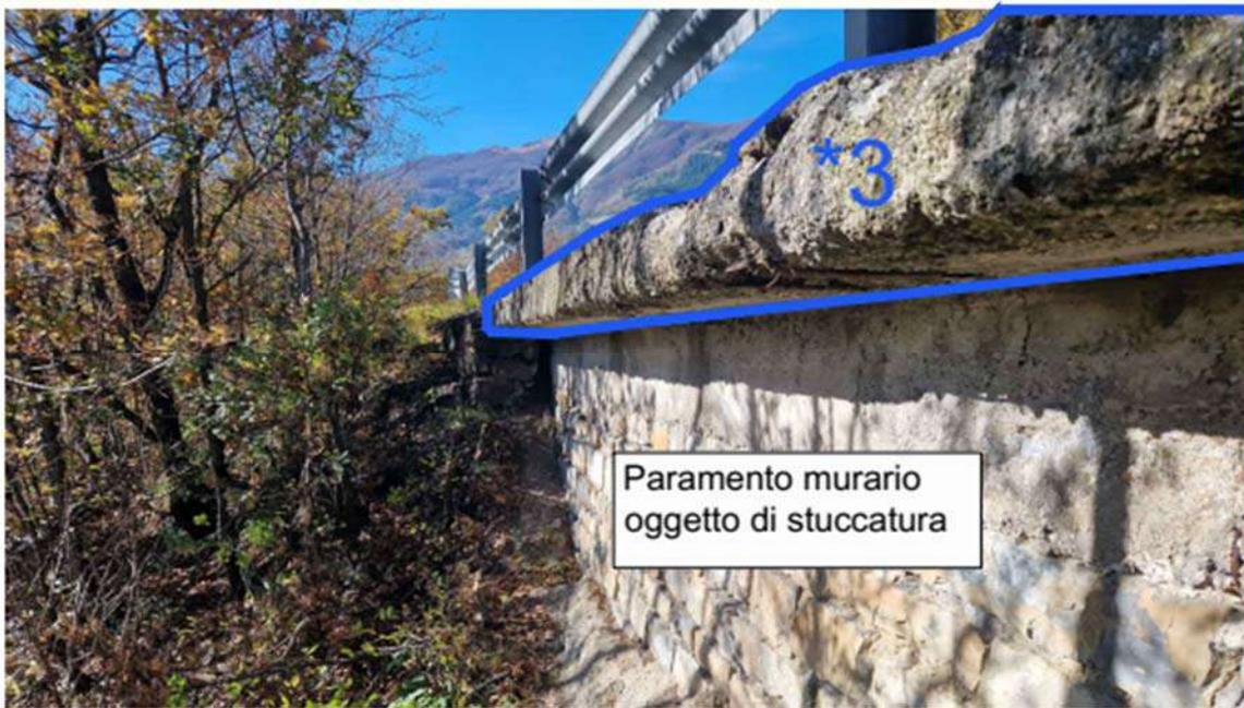
Figura 12 – Schema della soluzione progettuale ipotizzata per il manufatto di cui al punto c)
