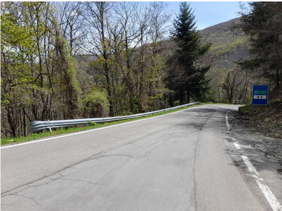
**Foto 6 – vista della pavimentazione stradale danneggiata e della barriera bordo laterale deformata e con cedimento della banchina**
