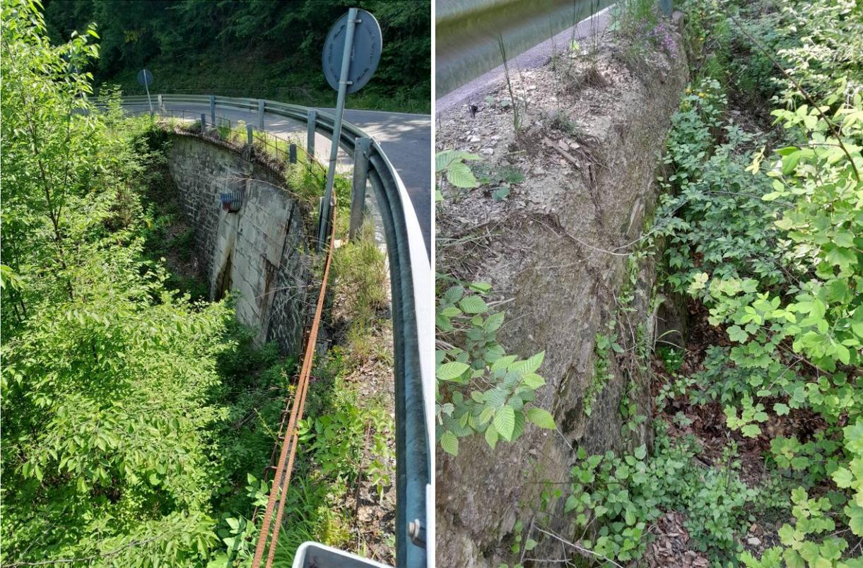
**Foto 9 – vista del muro sottoscarpa lato Sologno, con disgregazione del calcestruzzo del cordolo, perdita del copriferro ed ossidazione dell’armatura**
