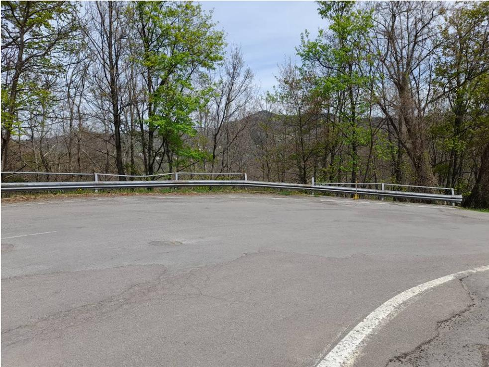
**Foto 5 – vista della pavimentazione stradale danneggiata e della barriera bordo ponte deformata**
