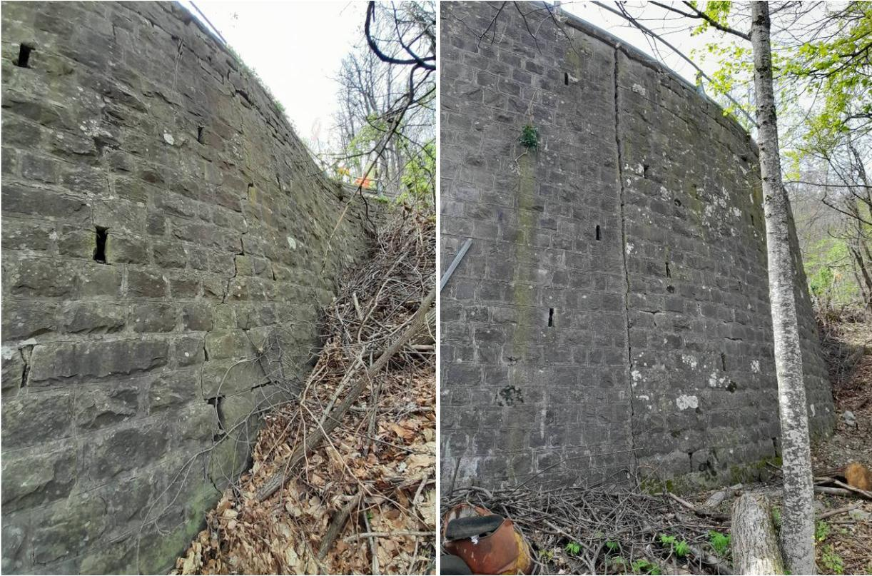
Foto 1 – vista del muro sottoscarpa con fessurazioni, all’intersezione con SP 18
