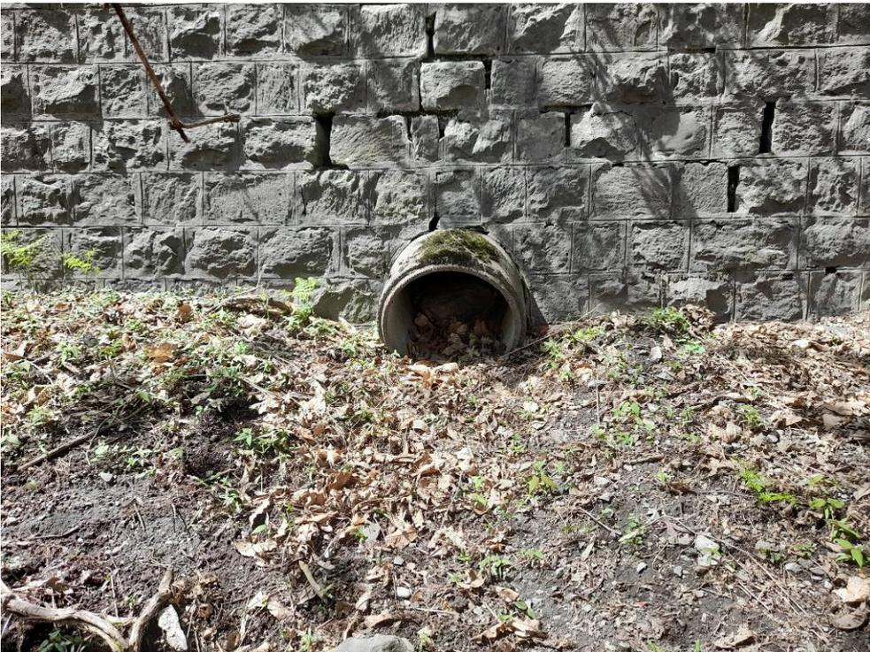
Foto 4 – vista del muro sottoscarpa con erosione dei giunti e dell'attraversamento idraulico parzialmente ostruito
