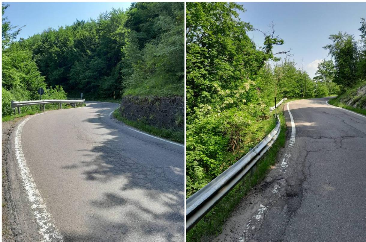
Foto 13 – vista della pavimentazione stradale deteriorata e della barriera non regolamentare
