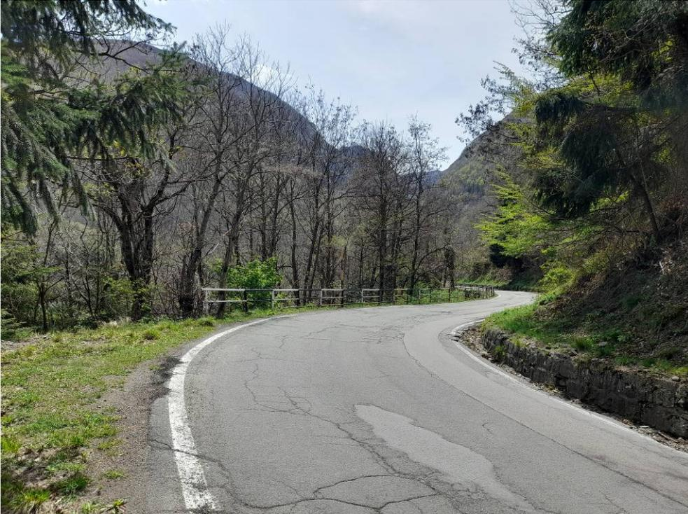
Foto 7 – vista della pavimentazione stradale danneggiata e del parapetto in tubolari metallici non regolamentare
