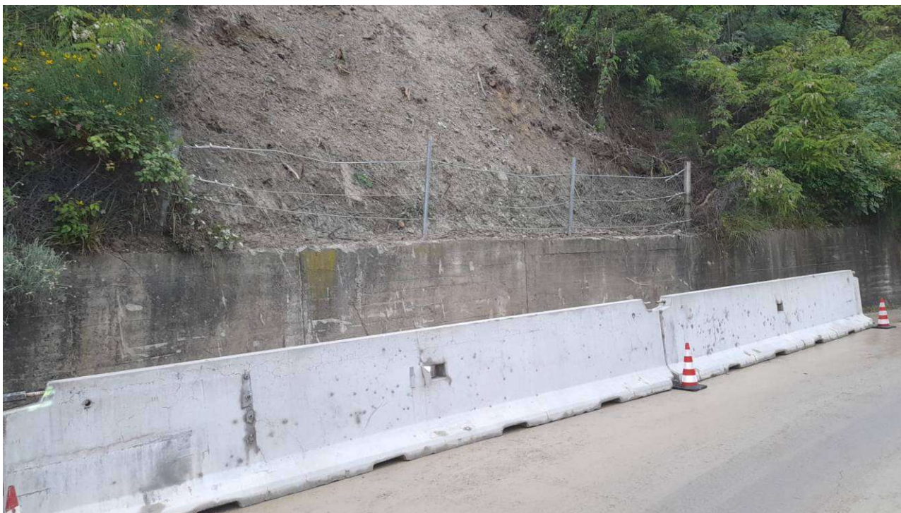
Foto 2 – Vista dell'intervento provvisorio per permettere la riapertura della strada provinciale.
