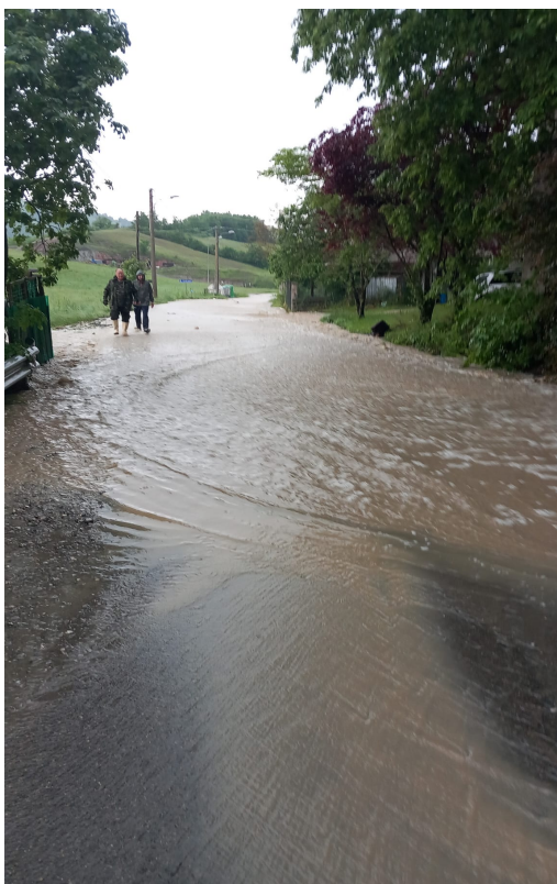
Foto 3 – Vista del tratto di strada allagato a seguito dell'otturazione dell'attraversamento idraulico.
