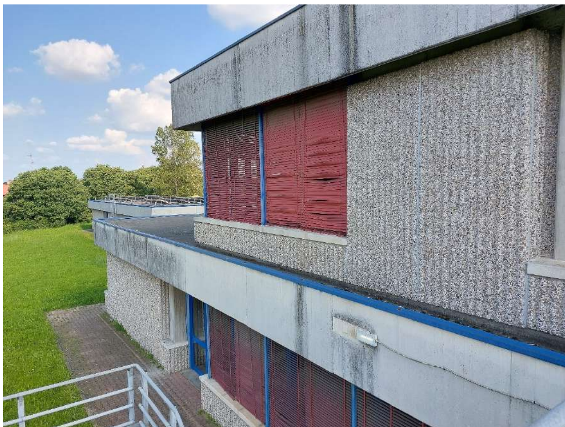
Lato SUD – U.S.2
