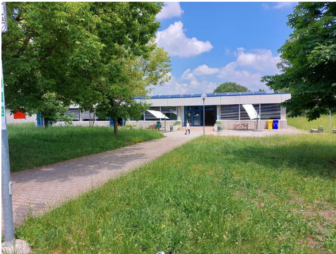
Lato SUD – U.S.3
