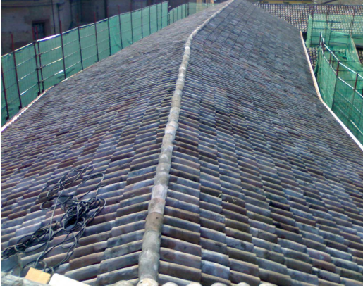
Intervento in copertura a conclusione dei lavori
