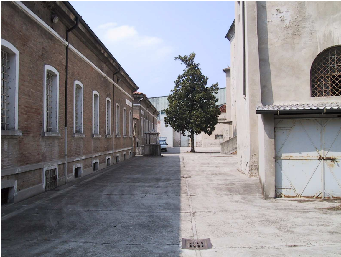
fronte interno con vista parziale sui padiglioni bassi
