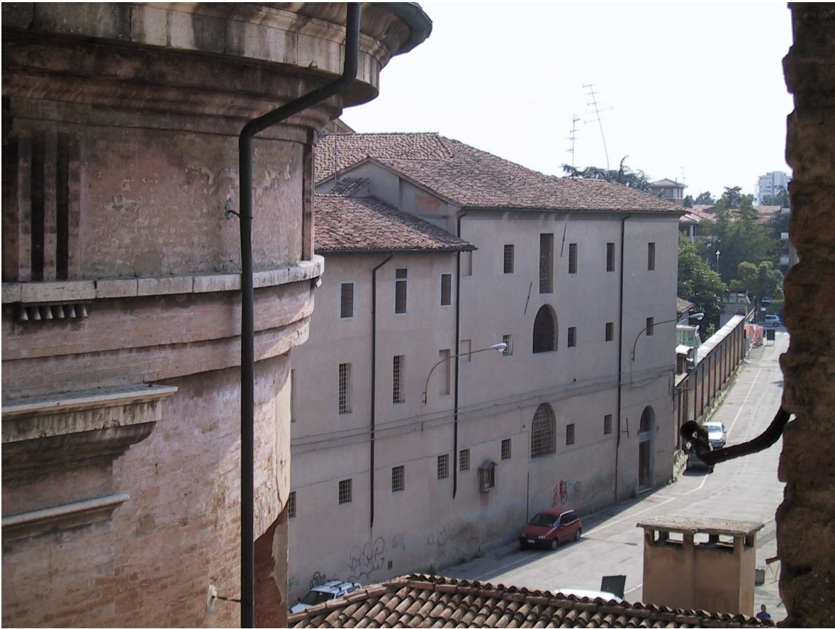
vista parziale fronte su via dei Servi
