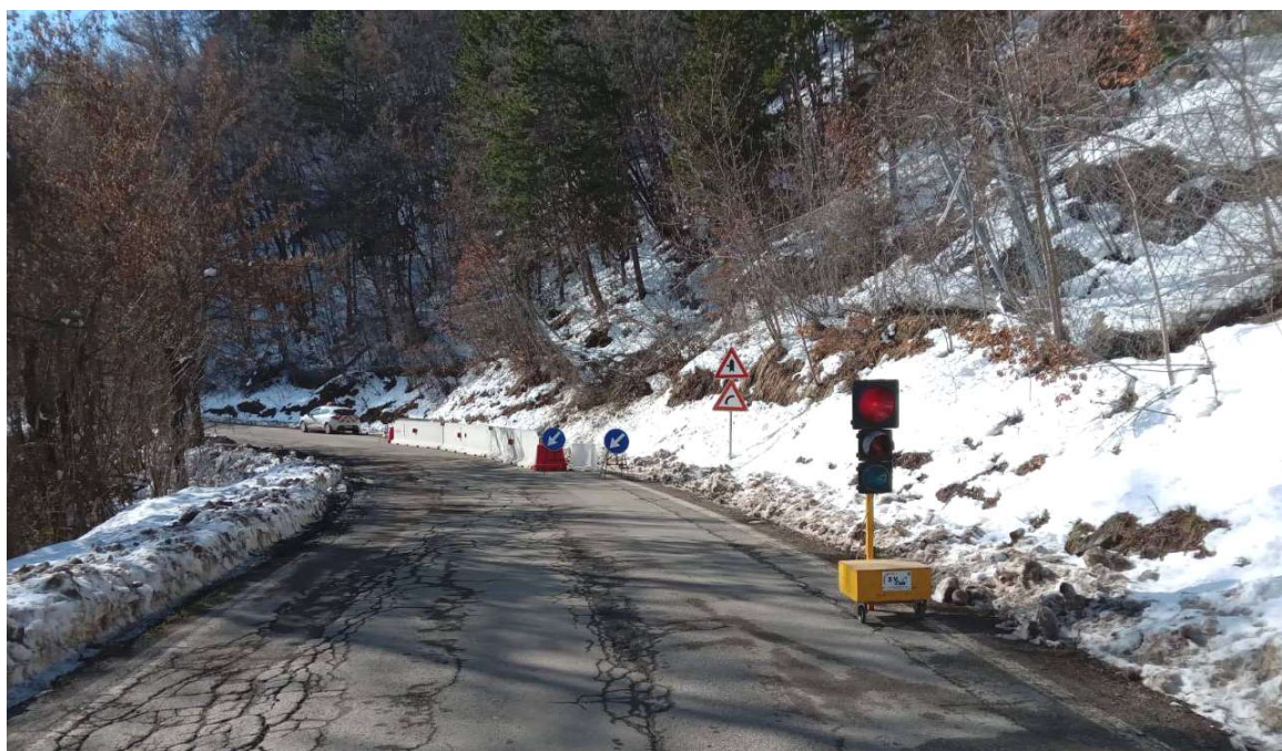
Foto 4 – Vista della strada provinciale dopo l'istituzione del senso unico alternato regolato da semaforo e posa dei new jersey in cemento a protezione della carreggiata stradale.
