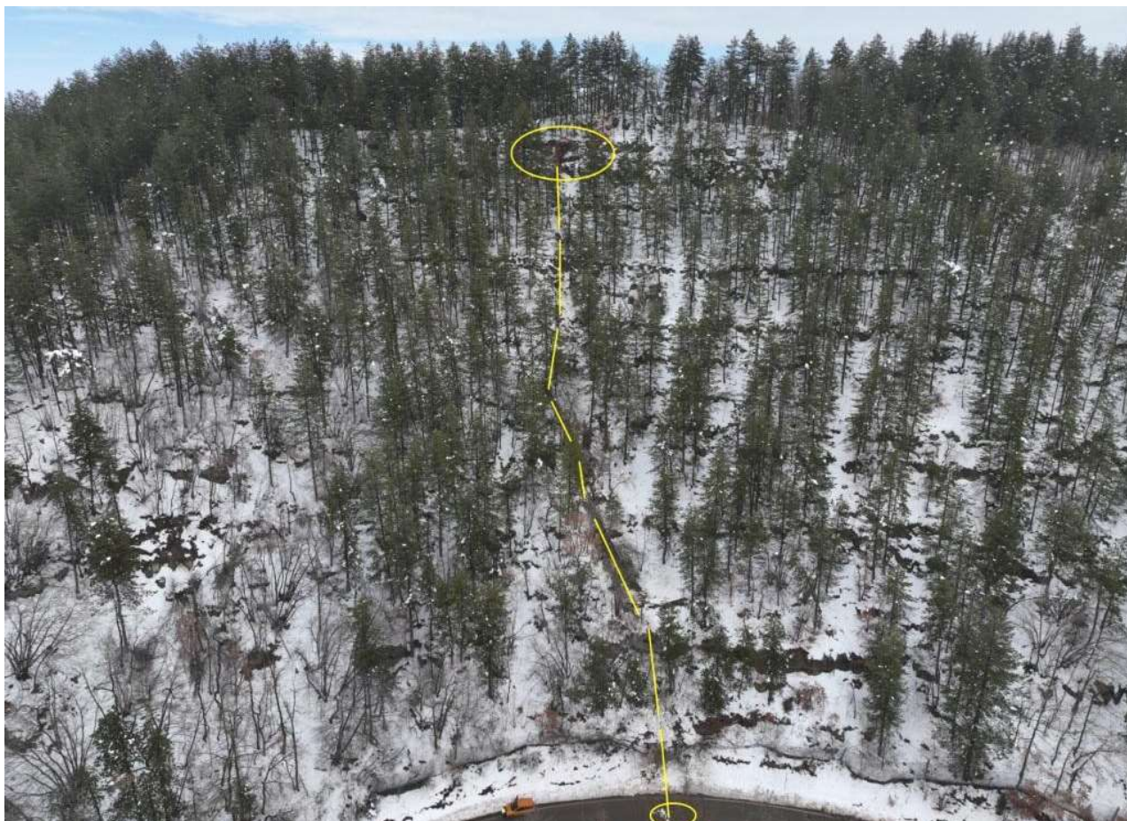
Foto 3 – Vista dal drone del percorso dei massi distaccati dalla sommità del versante ad una altezza di circa 75 metri dalla strada provinciale
