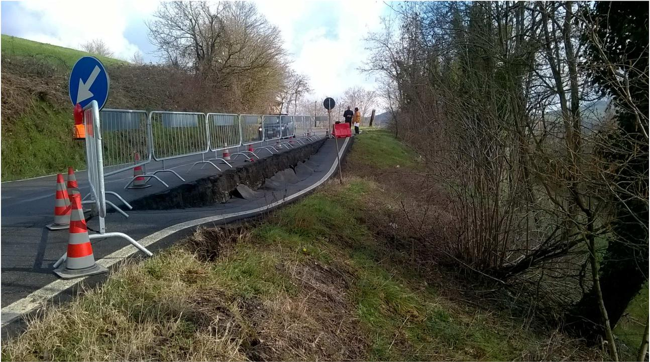
**Foto 1 – Vista della sede stradale interessata dal dissesto ed in particolare dell’abbassamento della porzione esterna della sede stradale.**
