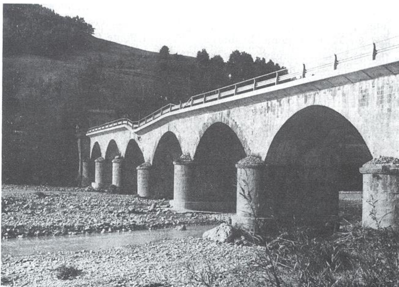
Figura 1 - Ponte sul F.Secchia in loc. Gatta - cedimento a seguito della piena del Settembre 1972
