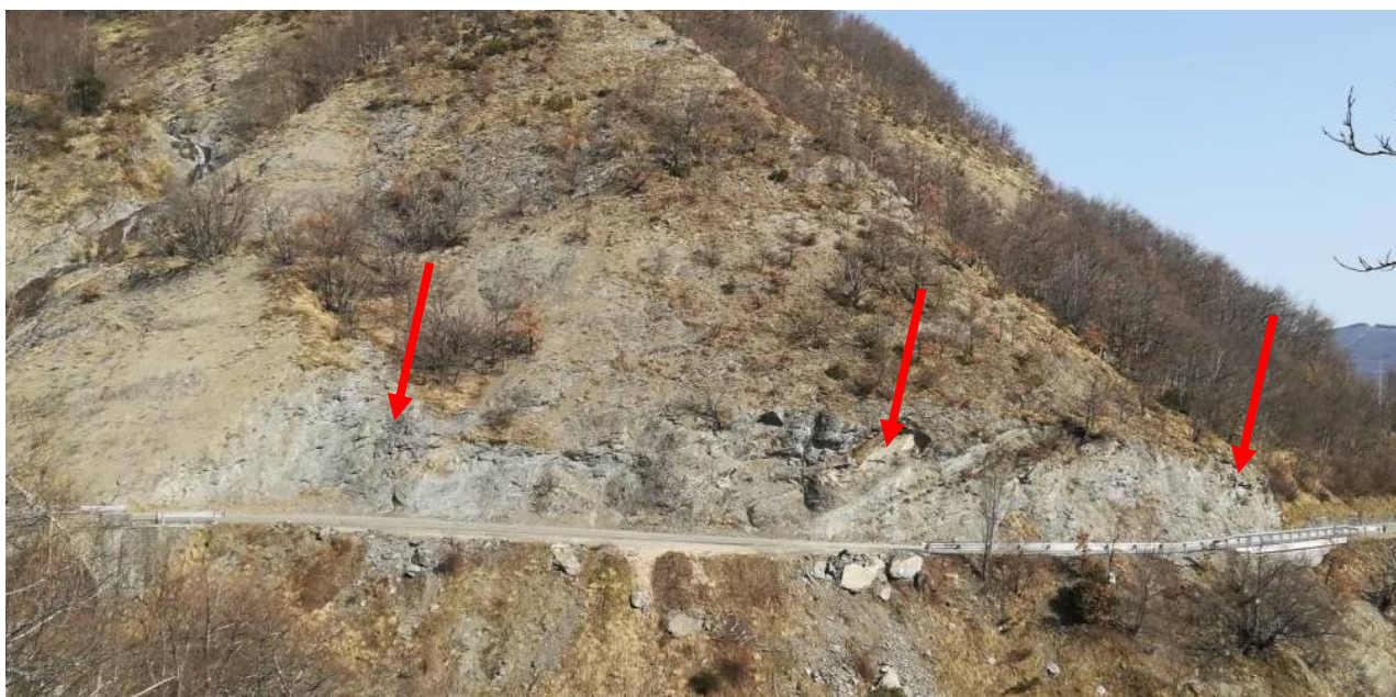
Foto 3 – Vista della scarpata di monte sulla SP 9 al km 33+00, ripresa dalla parte opposta del Rio Rumale, sono evidenziati i punti di distacco dei massi avvenuti nel tempo.
