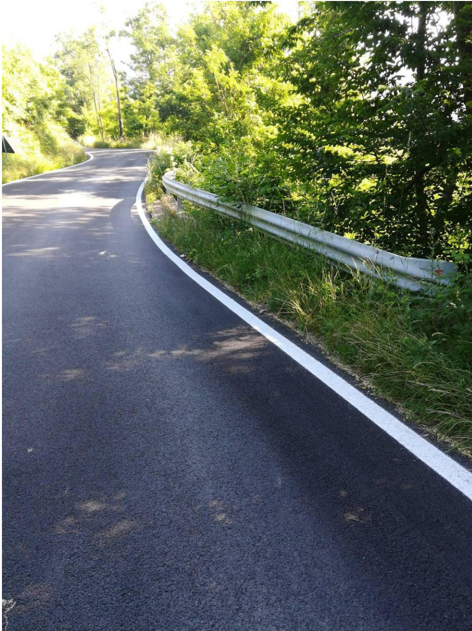
Foto 3 – Vista da monte del tratto di strada su cui insiste il manufatto dell'intervento di valle.
