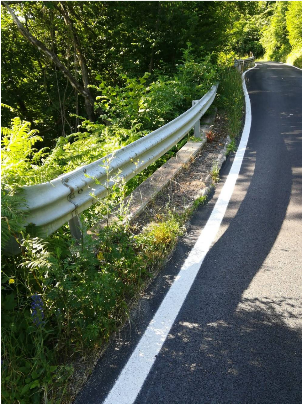
Foto 4 – Vista da valle del tratto di strada su cui insiste il manufatto dell'intervento di valle.
