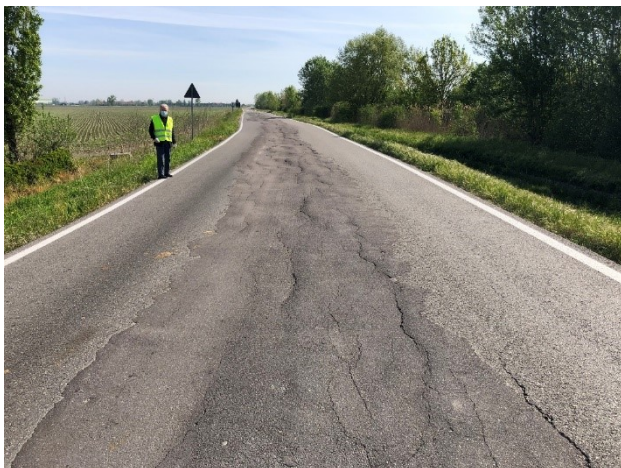
Figura 3 - Il dissesto del tratto di strada in prossimità della officina del Consorzio di Bonifica. In questo tratto si procederà all'allargamento del piano viabile a 8,50 m con stabilizzazione della fondazione stradale.
