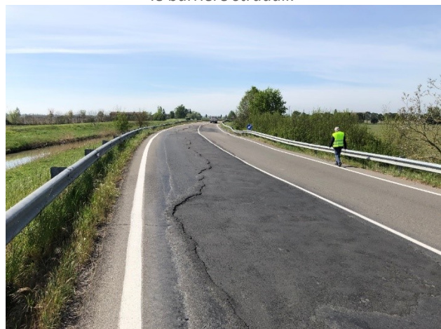
Figura 2 - Particolare degli effetti del movimento franoso alla destra della foto saranno infisse le palancole e sostituite le barriere stradali.
