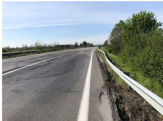
Figura 1 - Gli effetti del movimento franoso qui alla destra della foto saranno infisse le palancole e sostituite le barriere stradali.
