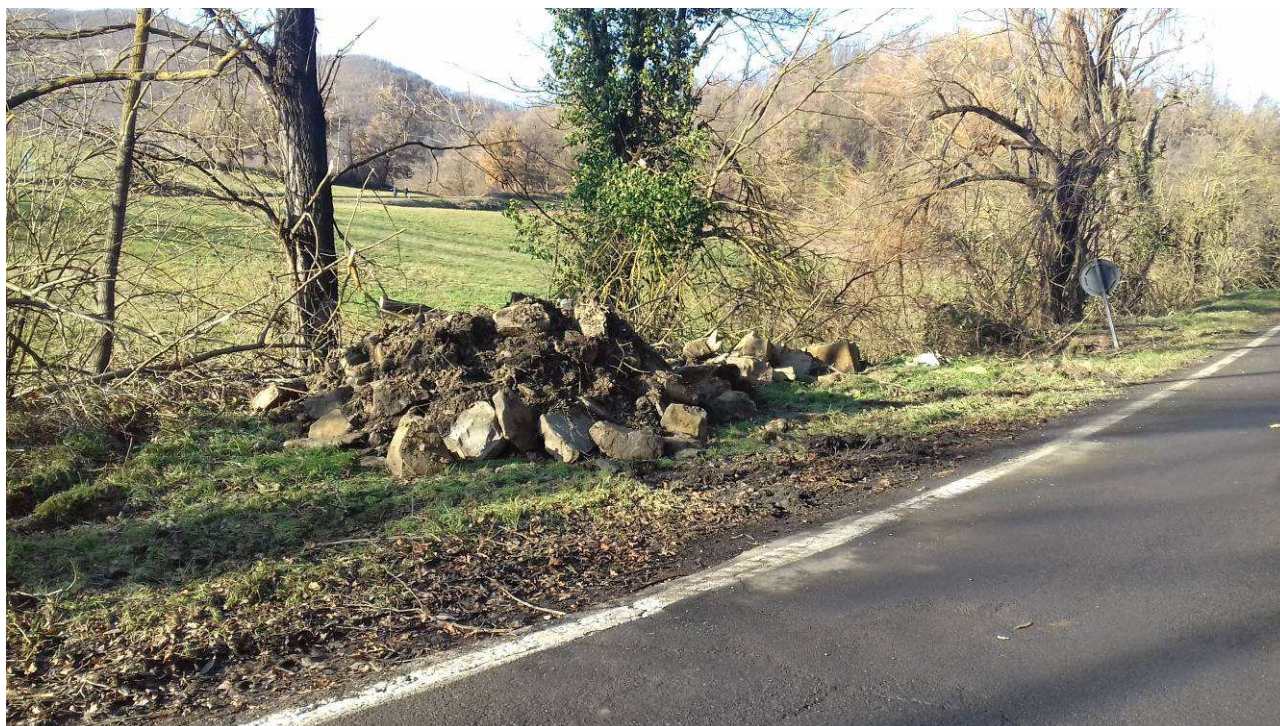
Foto 1 – Particolare dei massi crollati dalla scarpata e spostati ai margini della SP 57.
