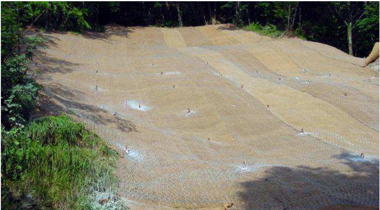
**Fig. 2 - Posa della rete con accoppiata la biorete in cocco e disposizione degli ancoraggi per il passaggio delle funi**
