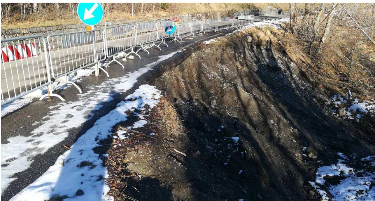
Foto 2 – Particolare dell'evoluzione del dissesto lungo la scarpata di valle, con cedimento completo della banchina stradale (05/02/2019).
