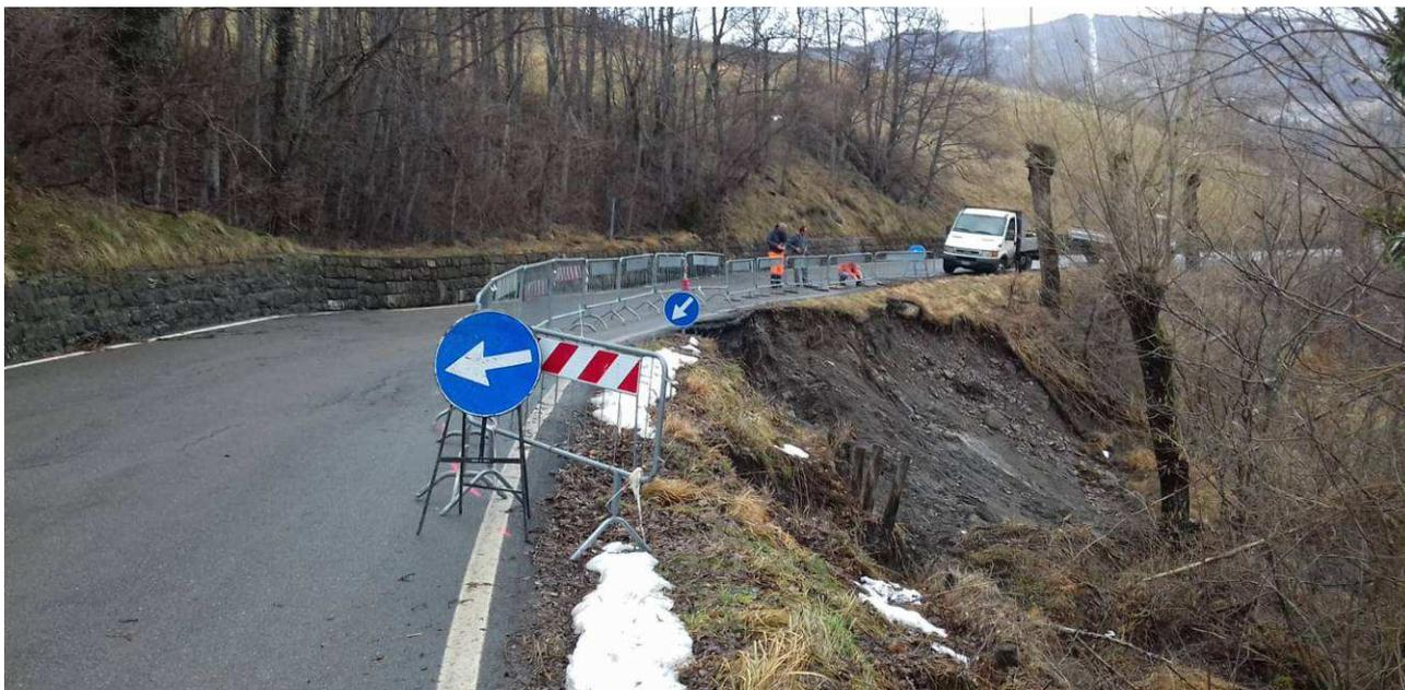
Foto 1 – Vista da ovest del dissesto che ha interessato la scarpata di valle, durante le fasi di istituzione del senso unico alternato a vista con limitazione della velocità (02/02/2019).
