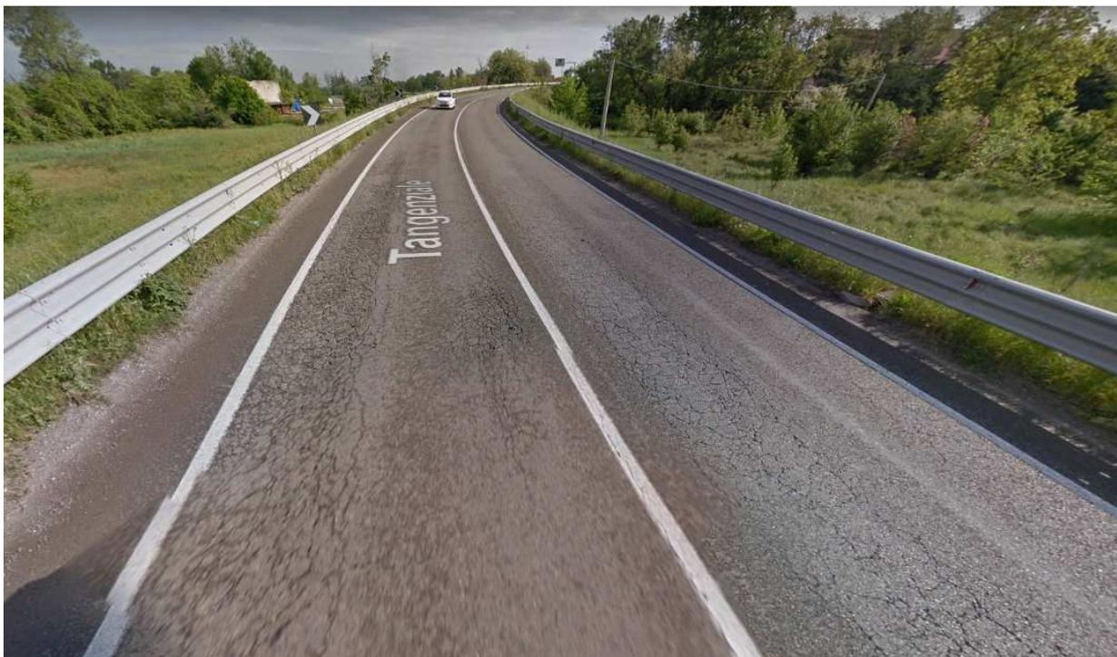
**Foto 2 – Particolari dei cedimenti della pavimentazione con la formazione di ormaie e depressioni e conseguenti fessurazioni a blocchi e a ragnatela nel tratto nord della variante di San Polo d’Enza.**
