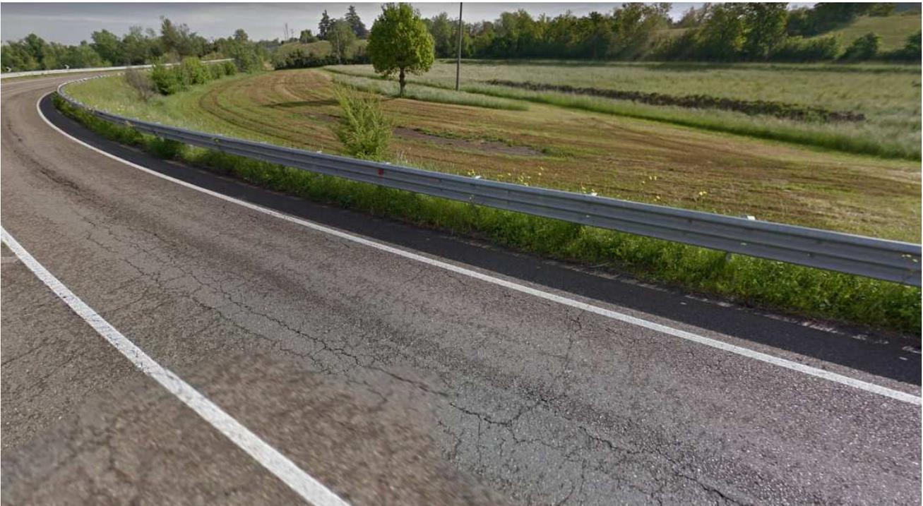
Foto 1 – Particolari dei dissesti della pavimentazione presenti sul tratto sud della variante di San Polo d'Enza, con fessurazioni a blocchi e a ragnatela.
