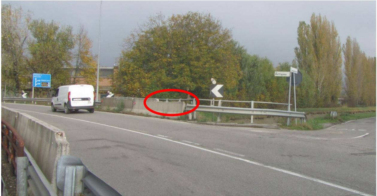
**Figura 3 Particolare del sistema di barriera esistente che come risulta evidente è stato parzialmente manomesso**
