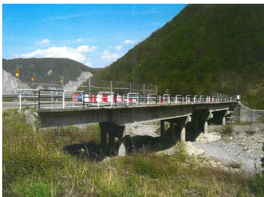
Foto 1 – Vista del ponte esistente sul Rio Sologno con intervento di emergenza dovuto al degrado (lato monte)
