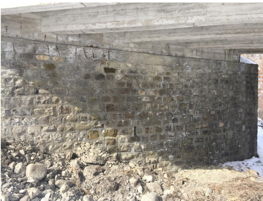
Foto 5 – Dettaglio della spalla sul lato Castelnuovo
