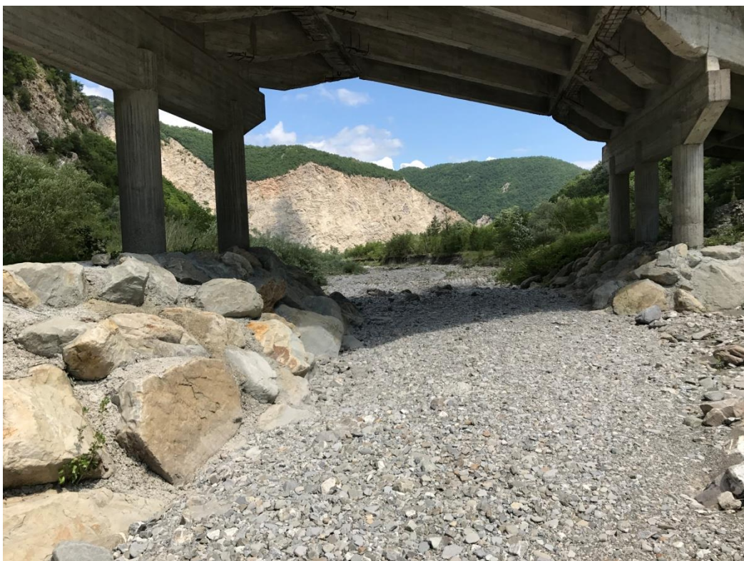
Foto 4 – Dettaglio delle pile esistenti
