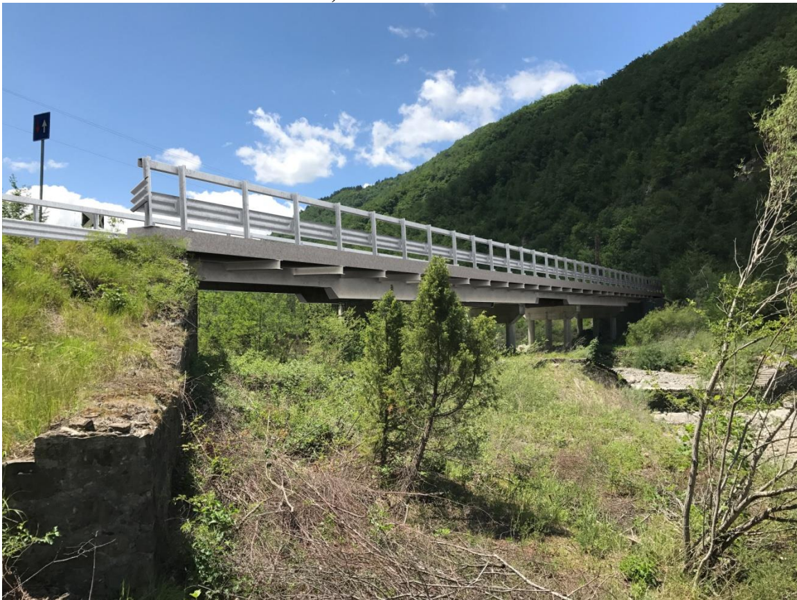
-Ripristino ponte sul Rio Sologno: vista lato valle-
