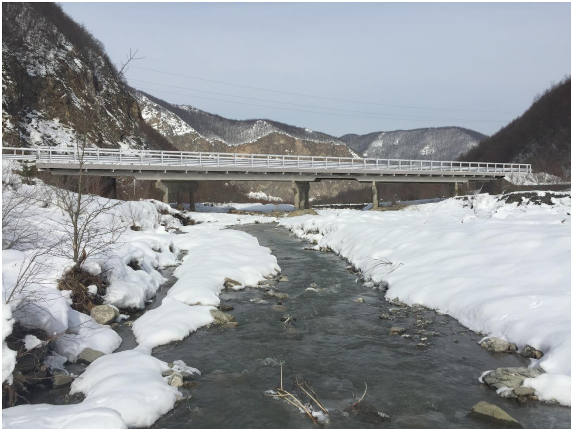
-Ripristino ponte sul Rio Sologno: vista lato monte-
