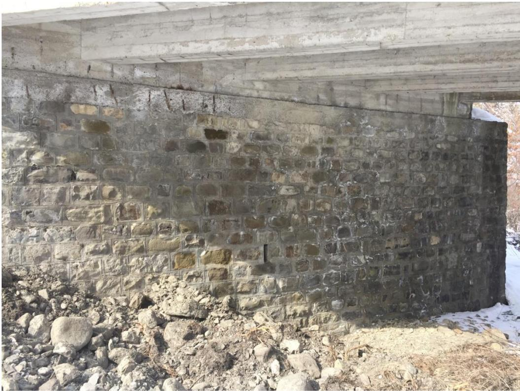
*Foto 5 – Dettaglio della spalla sul lato Castelnuovo*
