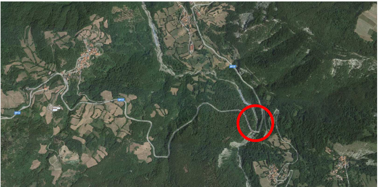
Fig. 1 – Vista aerea dell’area oggetto di intervento
