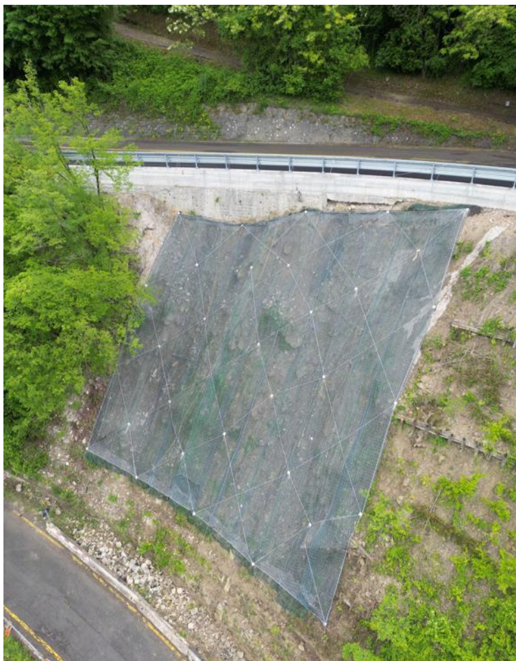
Vista dell'intervento completato a valle della 513
