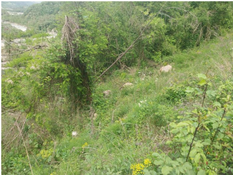
Presenta di alberature secche e trovanti instabili
