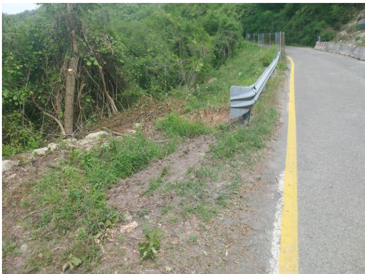
Partenza pista di cantiere
