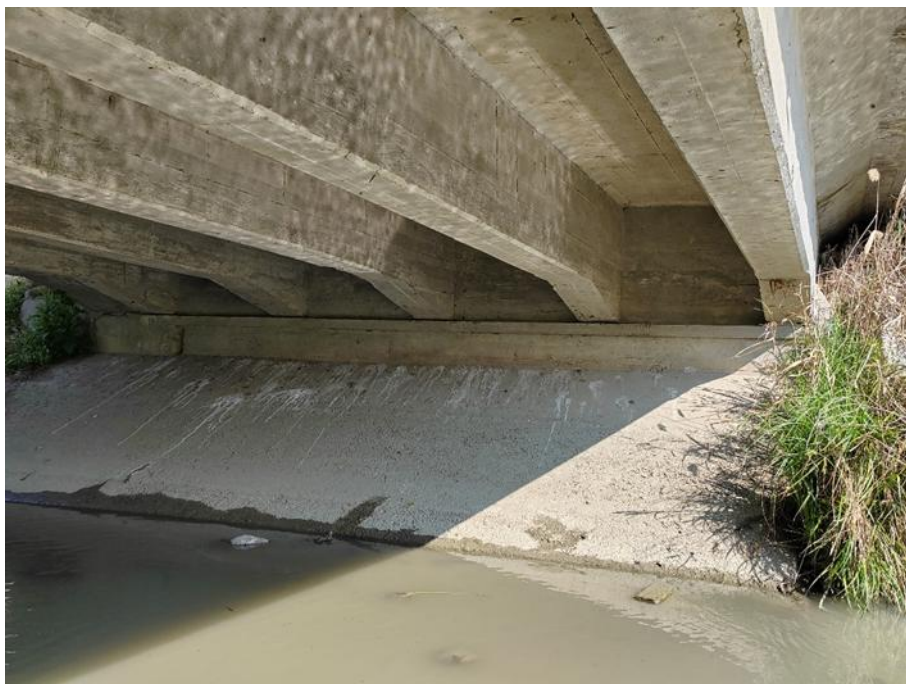
Figura 2.6: Vista da intradosso impalcato
