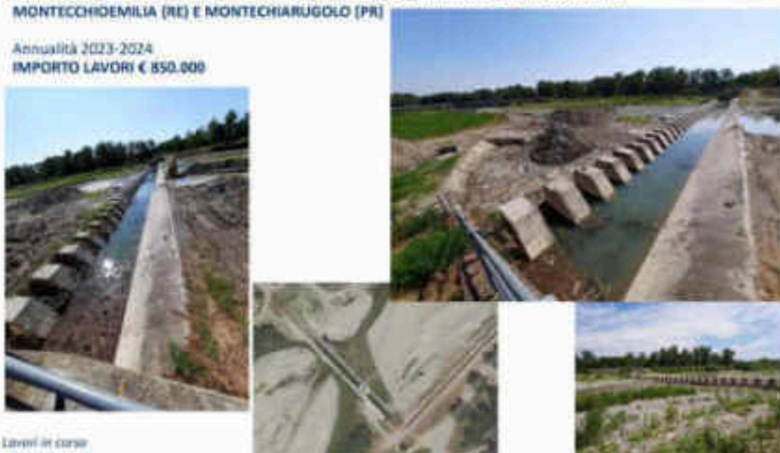
Figura 82 – Lavori di manutenzione straordinaria dei manufatti al servizio delle casse di espansione sul t. Enza (fonte: AiPa) – 3 di 3
