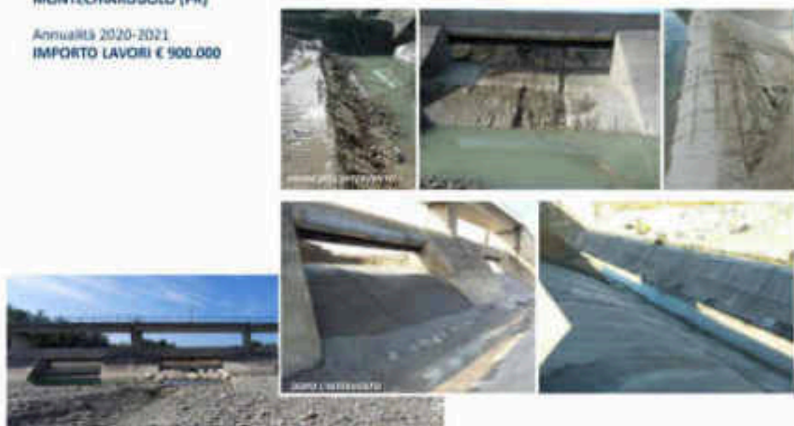
Figura 80 – Lavori di manutenzione straordinaria dei manufatti al servizio delle casse di espansione sul t. Enza (fonte: AIPo) – 1 di 3
