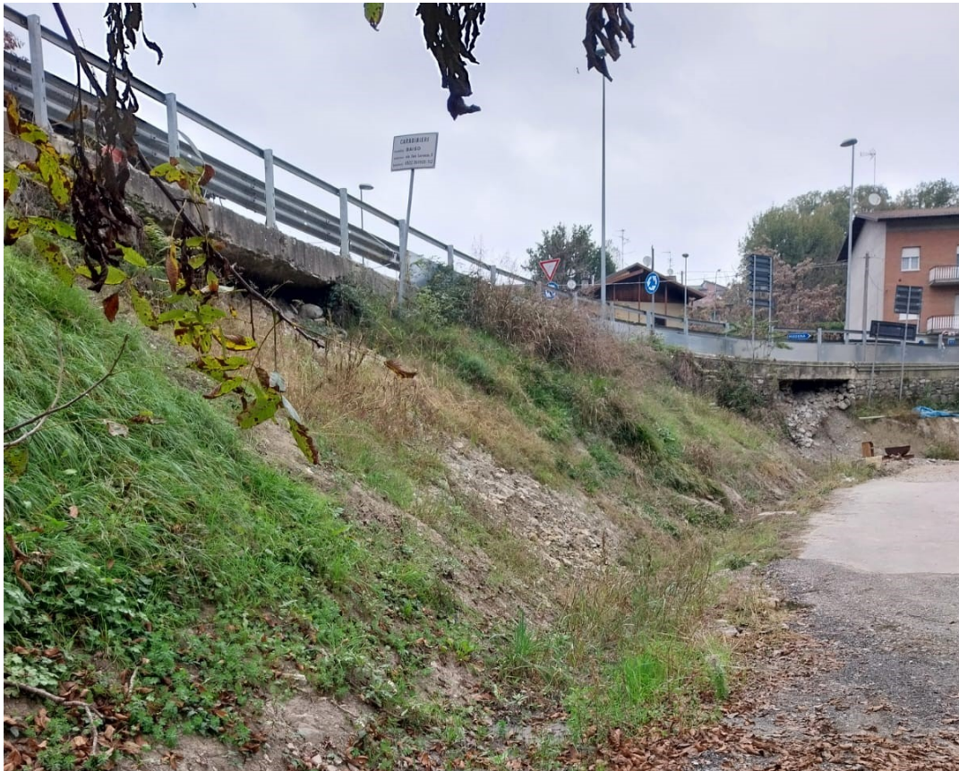
Foto 1 – Scarpata di valle oggetto d'intervento.
