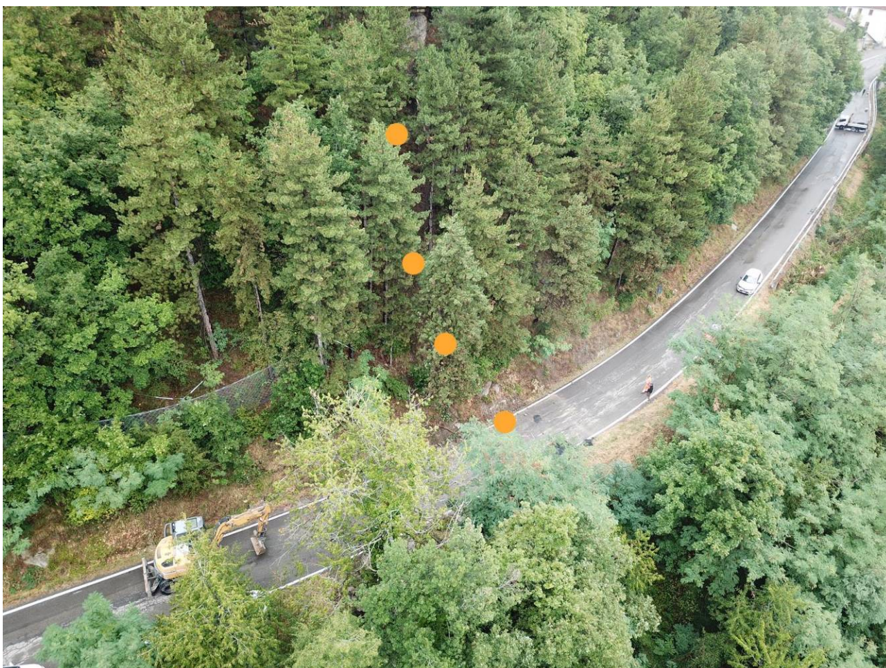
Foto 1 – Vista della scarpata di monte della SP 8 al km 11+900 con indicati il punto di distacco e la traiettoria dei massi.
