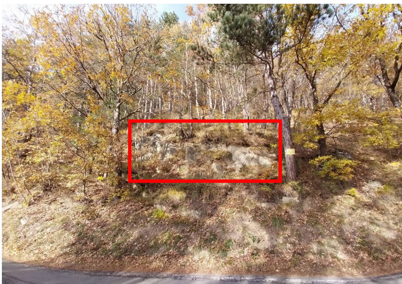
Foto 6 – Particolare del pendio in cui la bancata arenacea in affioramento nella parte basse del pendio, che restando al di sotto della barriera paramassi, verrà messo in sicurezza mediante la posa di rete paramassi (porzione con riquadro in rosso).
