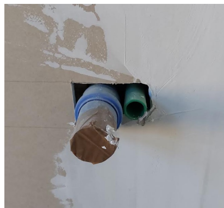
DETTAGLIO ACQUA FREDDA E SCARICO
